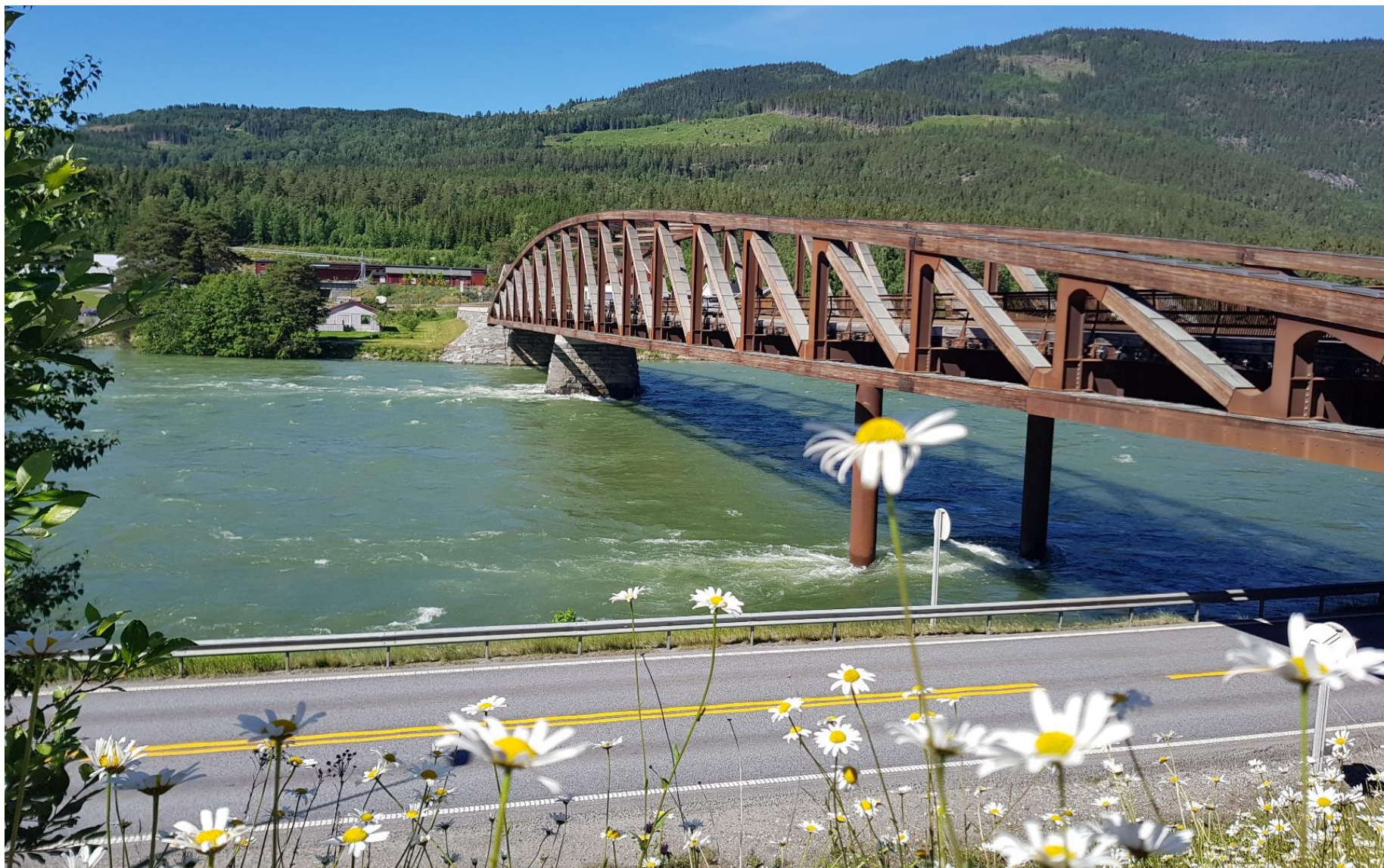
Tretten bru 2012. Foto: Steinar Svensbakken
