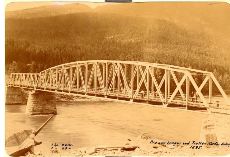
Tretten bru, bygd i 1895. Foto: Nikolai Olaf Saxegaard/Norsk vegmuseum.
