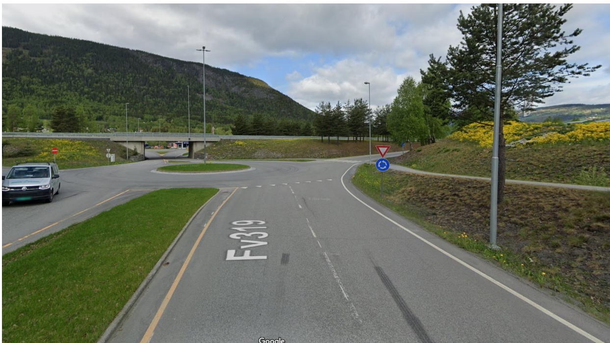
Figur 16: Kryssområdet sett østfra mot E6. Eksisterende gangveg til høyre, med østre rundkjøring og oppmerket gangfelt over nordgående påkjøringsrampe til E6.
