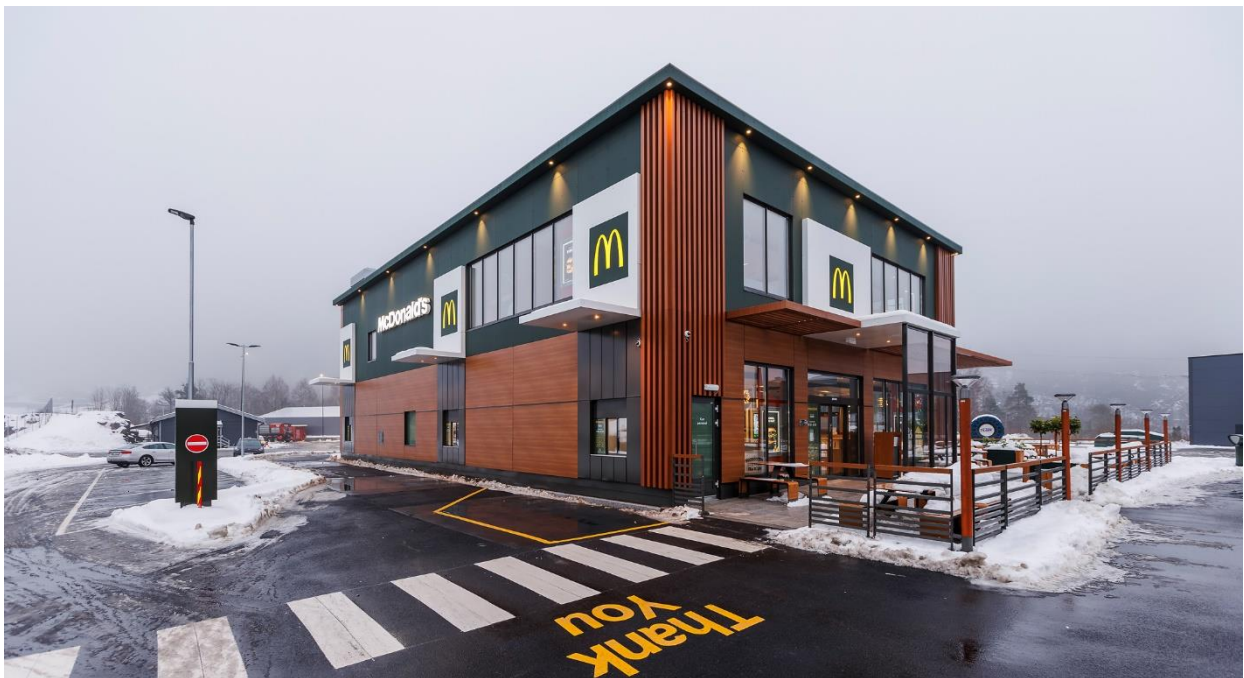
Figur 9: Eksisterende restaurant E18 Rugtvedt ved Stathelle (Linje Arkitektur AS)
