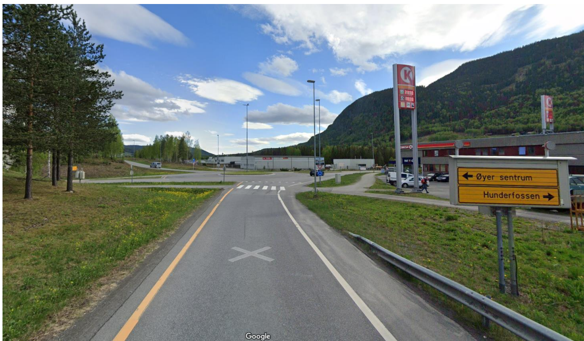
Figur 17: Kryssområdet sett nordfra i avkjøringsrampe fra E6, med vestre rundkjøring og oppmerket gangfelt over nordgående påkjøringsrampe til E6.
