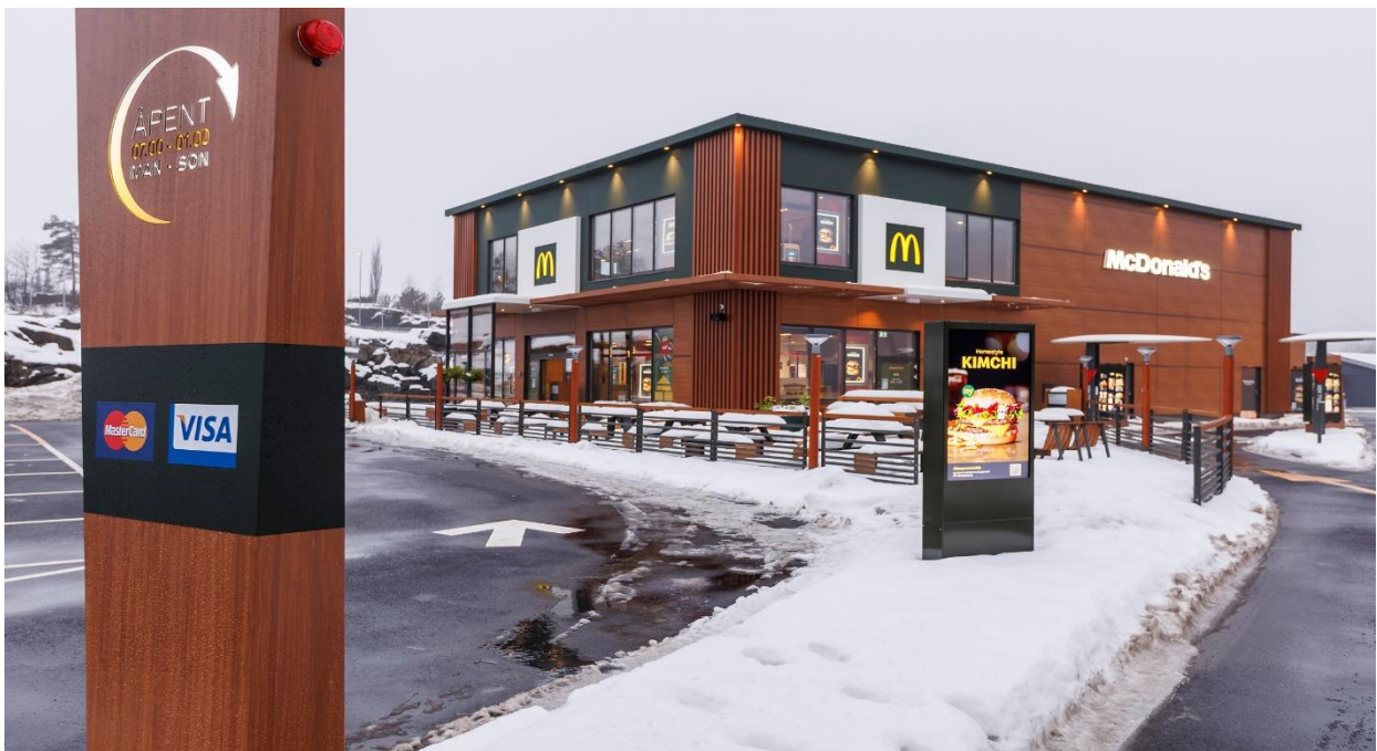
Figur 11: Eksisterende restaurant E18 Rugtvedt ved Stathelle (Linje Arkitektur AS)
