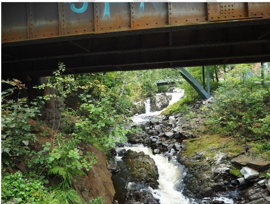
Mesna – sett østover fra eks. gangbru
