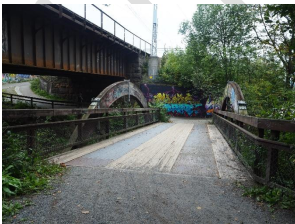
Gangbru over Mesnaelva – sett fra Lurhaugensiden
