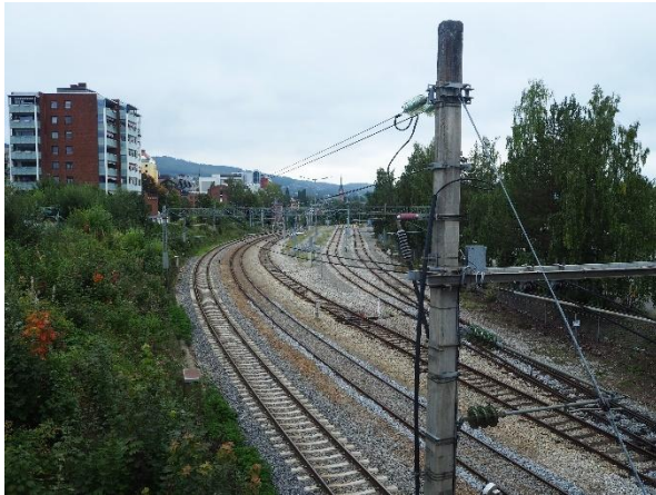
Jernbaneområde - sett fra nord/Løkkegata
