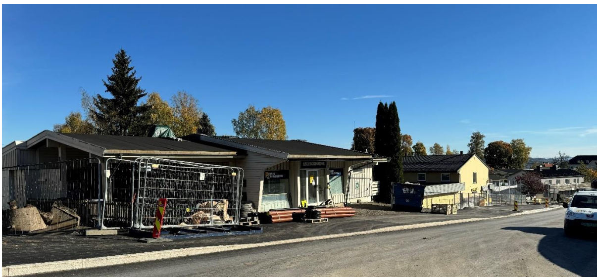
Figur 2-4 Eksisterende næringsbebyggelse som brukes som anleggskontor under utbyggingen av Prost Bloms gate (Foto: Norconsult Norge AS)
