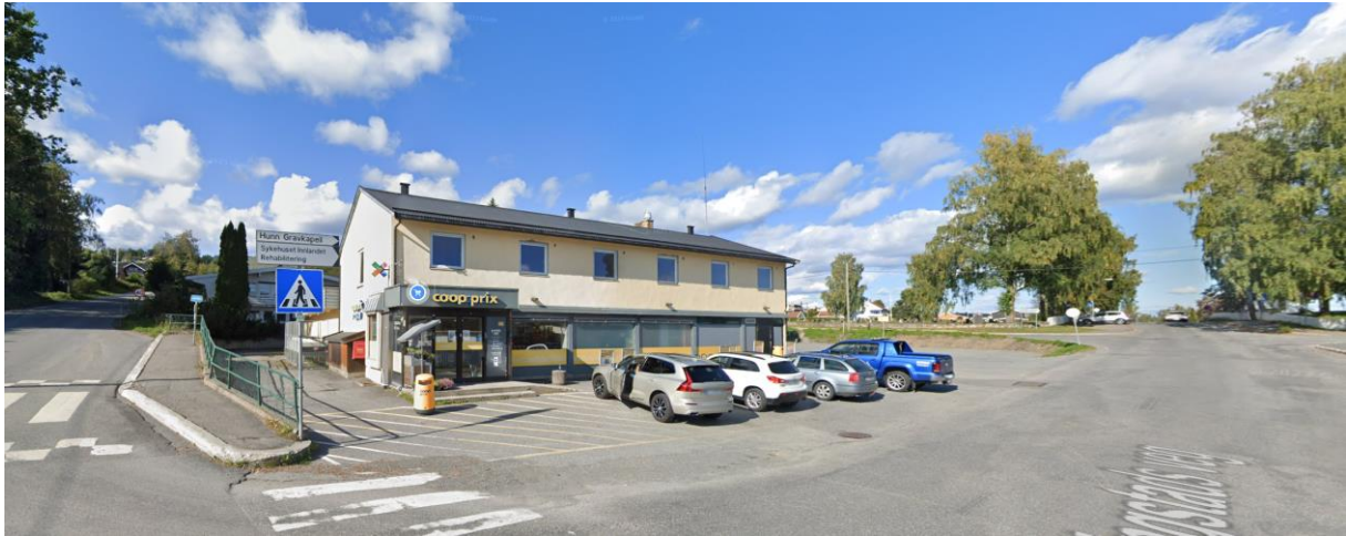
Figur 2-17 Dagens situasjon foran Coop prix. Kilde: Google street view
