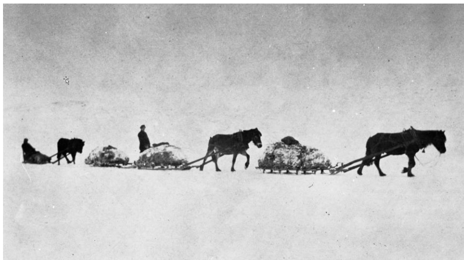
Hestetransport på vinterføre i Nord-Østerdalen - Kilde: https://digitaltmuseum.no/
