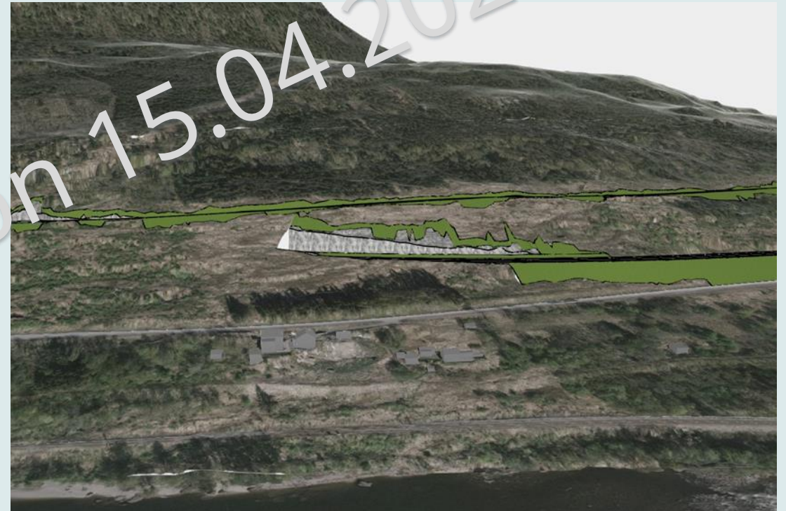
Tunnelportal øst for Rosenlund, driftsvei høyere opp i lia
