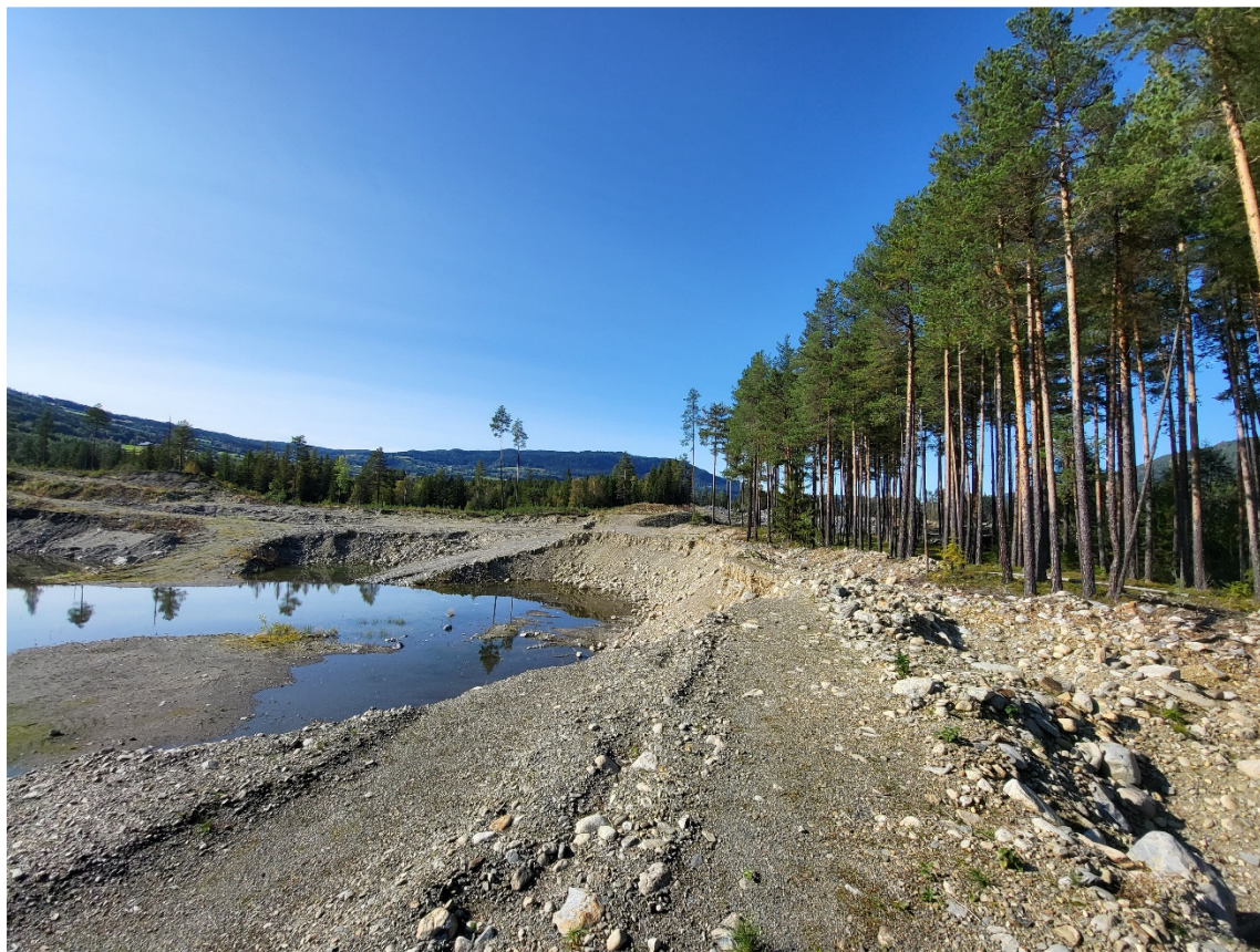
Grunnvannet synes i et parti ved uttaksområdets nordre avgrensning der det er gravd ned til et høydenivå på ca. 308 moh. Bilde ble tatt 14.09.2024.
