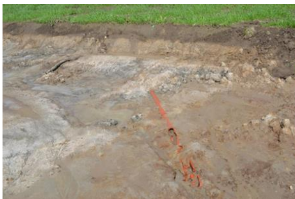
Figur 3-10. Avgravde grøfter på Bogstad, Oslo (til venstre), brudd på grøfterør som gir utlekking av vann over stort område på tilbakestilt jordbruksareal på Bogstad, Oslo (til høyre) (Foto: Trond Knapp Haraldsen).
