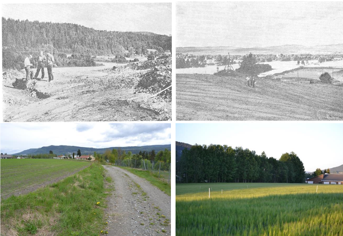
Figur 3-1. Jordflytting på Steinberghaugen: Areal klar for påfylling av jord (øverst til v.), ferdig opparbeidet jordbruksareal etter flytting av jord (øverst til h.) (Låg 1981), kornåker på flyttet jordsmonn (1,2 m tykkelse til v. for vei), frodig byggåker på flyttet jordsmonn (nederst til h.) (foto: Trond Knapp Haraldsen).
