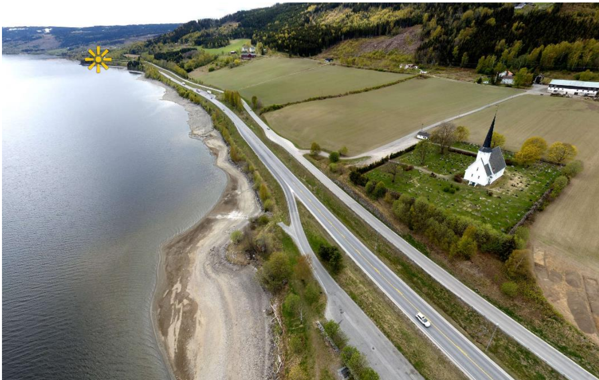
Figur 5-12. Fra Stranda til Vingrom kirke går ny E6 langs eksisterende europavei tett på Mjøsa. Mellom fjorden og vegen er det smale og til dels fraværende kantsoner og flere steder går vegfyllingen helt ut i Mjøsa.
