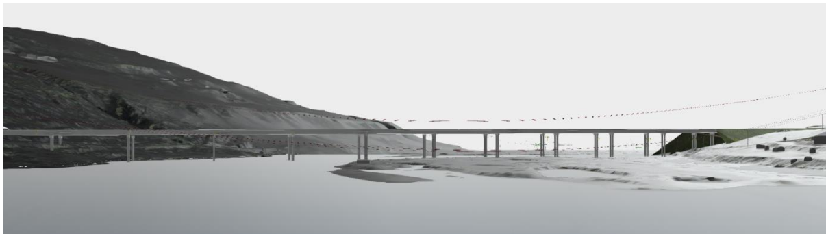
Figur 5-42. Planprogramløsningen gjør at brua flyttes ca. 100 meter nordover. Den nordlige og øverste ledningen krysser over brua. Den nedre ledningen vil henge et stykke sør for elva og høydemessig ligge midt i frihøyden under brua. Som for øvrige løsninger er samvirkningen mellom bru og ledninger meget uheldig.
