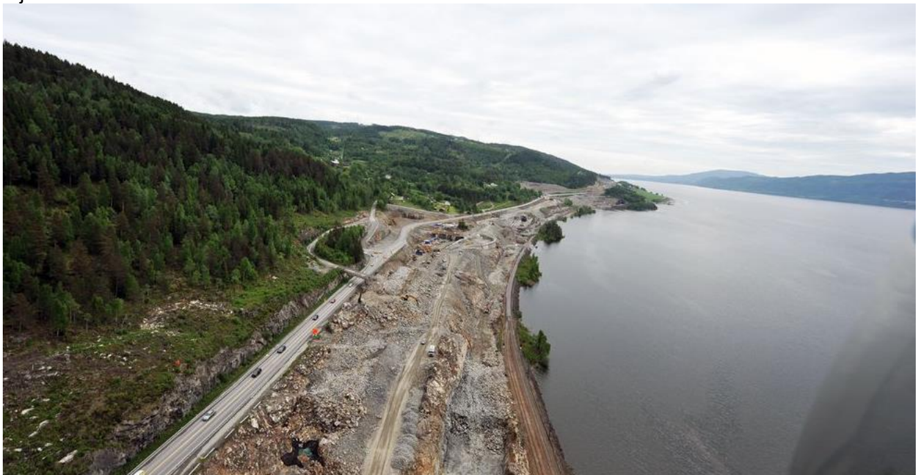
Figur 8-1. Fellesprosjektet E6 og ny Dovrebane langs Mjøsa endte opp med å bli lagt på fyllinger i strandsonen over flerfoldige kilometer. Prosjektet føyer seg med dette inn i rekken over store tunge inngrep som har fragmentert kantonene og endret gruntvannsområdene langs Norges største innsjø.
