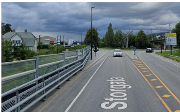
Dagens situasjon i området sett fra Storgata, fv.213
