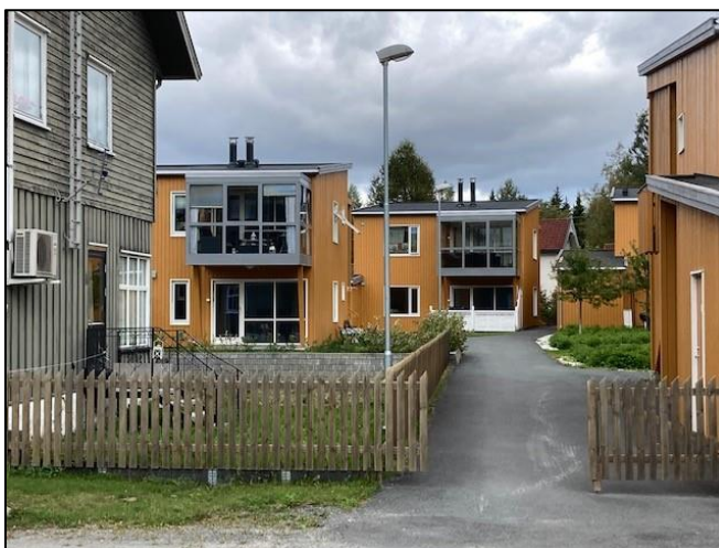
Bygg nr. 14 «Fagerlundtunet»
