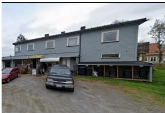
Bygg nr. 15 «Chicago Nordre»/ Fjordgata 17
