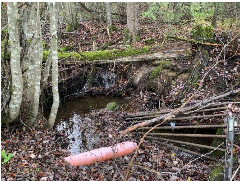
Figur 18 Dagens inntak lukking 3.
