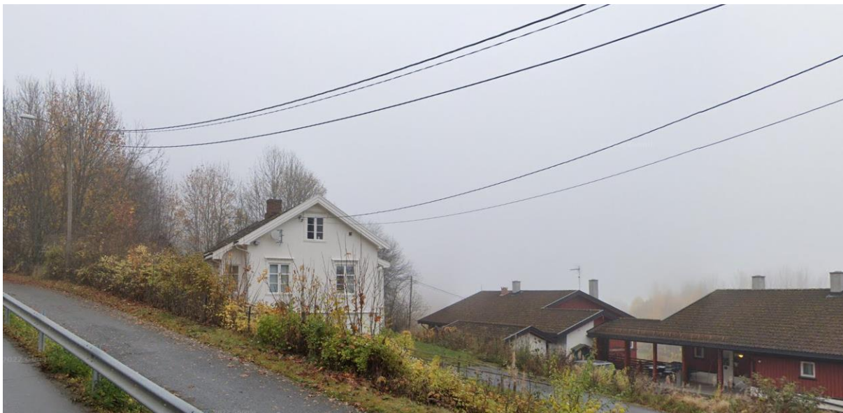
Figur 18: Bilde som viser SEFRAK-registrert bolig (t.v.) som ligger øst i planområdet (kilde: Google Maps, okt. 2022).
