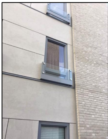
Figur 4-10: Glassfelt som skjermer den åpningsbare delen av et vindu for å skjerme for støy.
