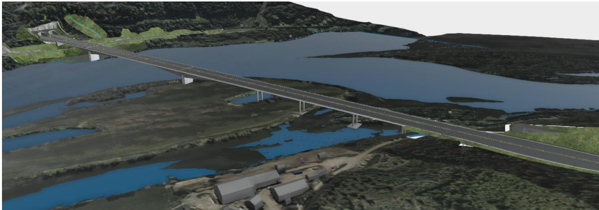
Figur 1-14. Lågen bru i justert linje, fritt frembygg-bru
