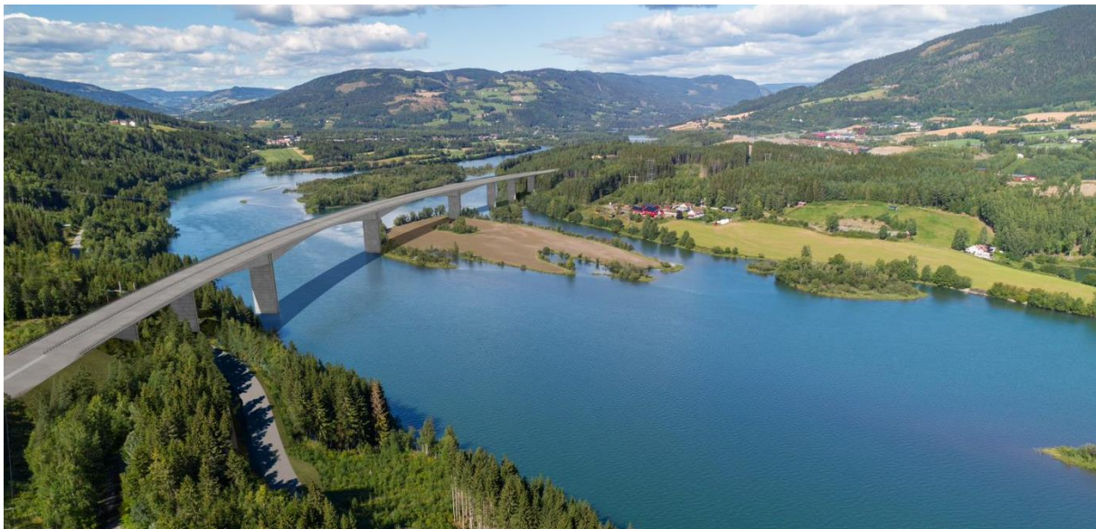
Figur 1-15. Lågen bru i kommunedelplanlinjen, fritt frembygg-bru
