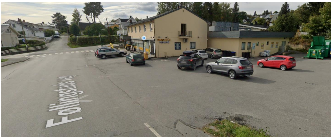
Figur 4-7: Utkjøring fra parkering til Føllingstads veg, sett mot sør. Kilde: Google street view.
