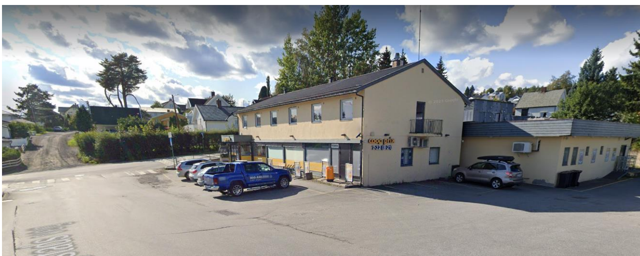
Figur 4-14: Dagens parkeringsløsning foran eksisterende butikk hvor kjørevegen benyttes som manøvreringsareal. Kilde: Google street view.
