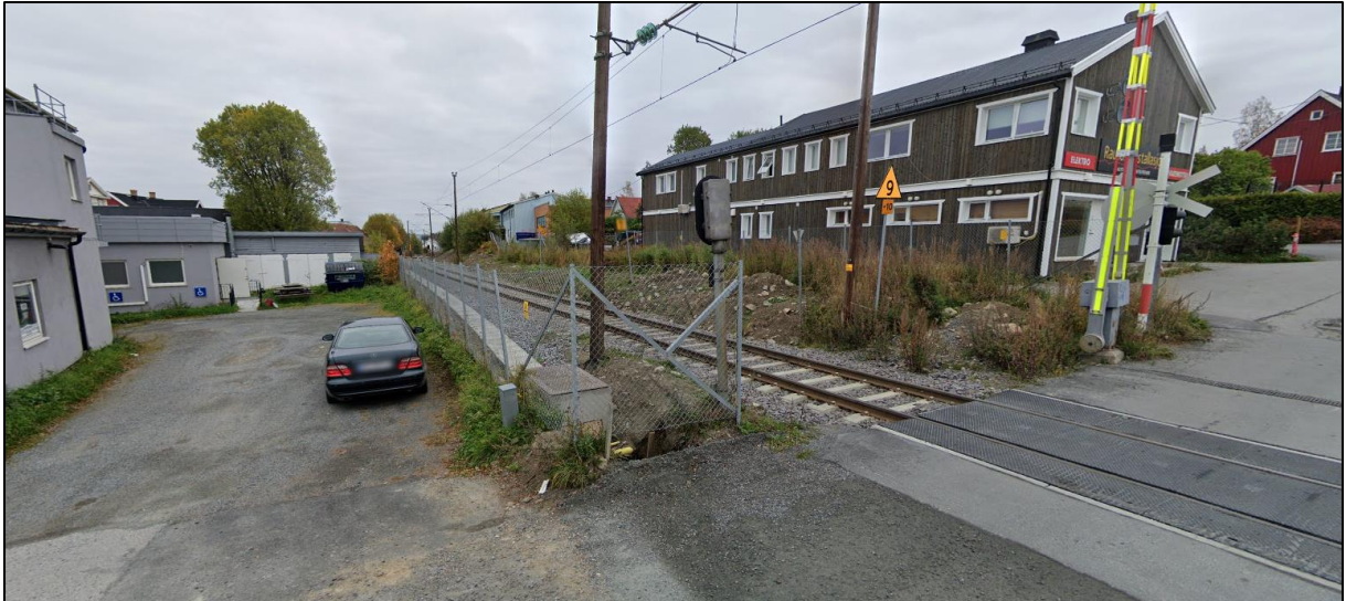
Figur 7, Kryssområdet mellom jernbanen Korterudsvingen (Google Maps).
