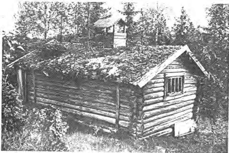
Koie ved Veltdammen, sett fra sør
