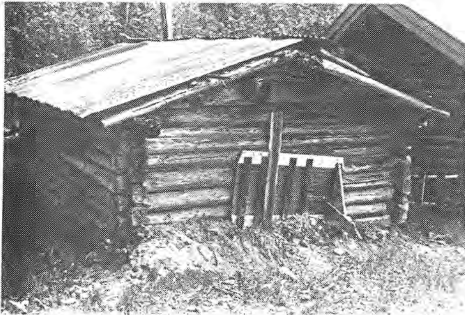
Stall (uthus), Storbronkdammen, sett fra øst
