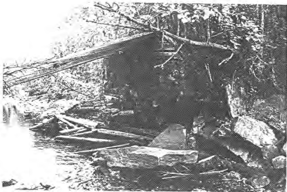
Detalj av damkar, sett fra øst
