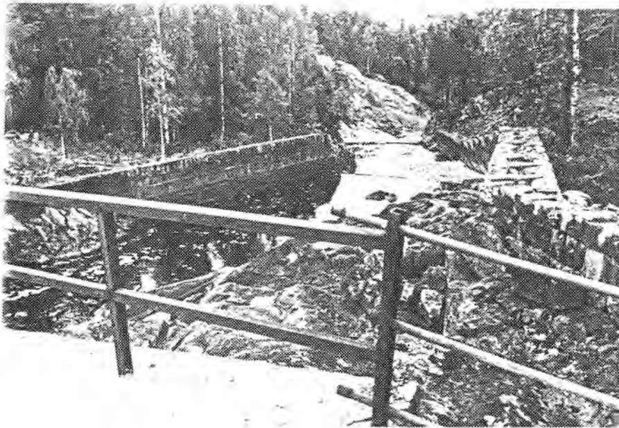
Golvinger i Haldammen, sett fra sør
