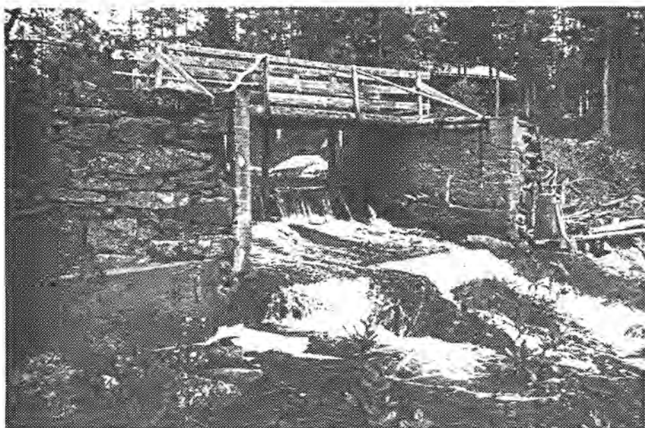
Detalj av damkar, sett fra nord/øst
