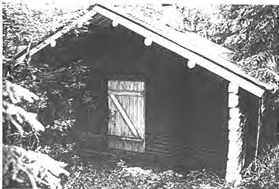
Koie ved Sætermyrdammen, sett fra nord
