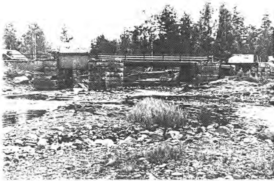
Haldammen, sett fra sør
