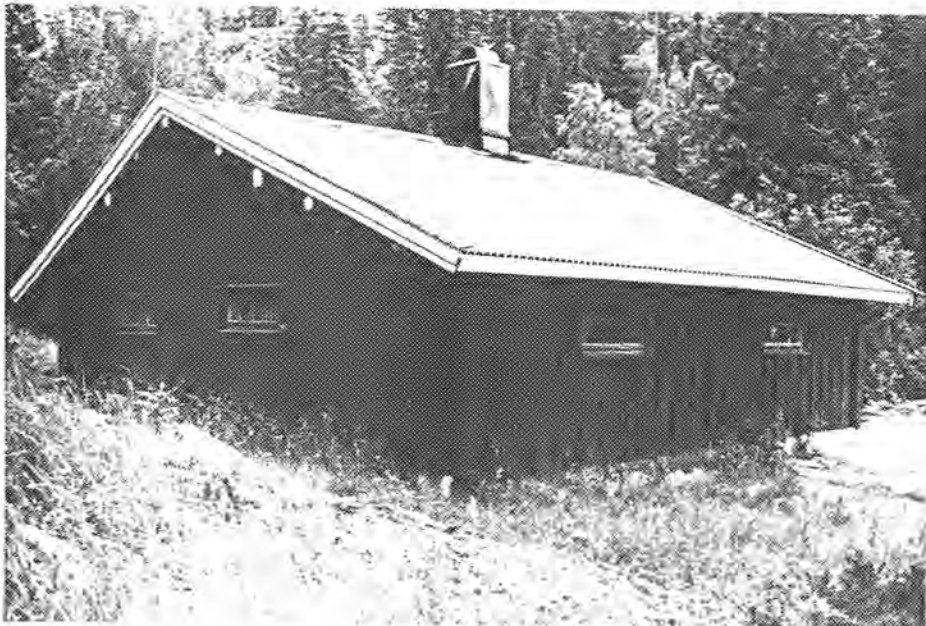
Koie ved Eidsmangdammen, sett fra øst
