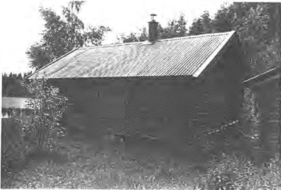
Damkoie ved Storbronkdammen, sett fra sør/vest
