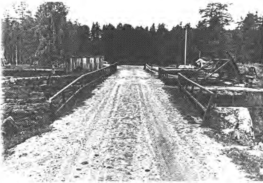
Dambru, sett fra vest
