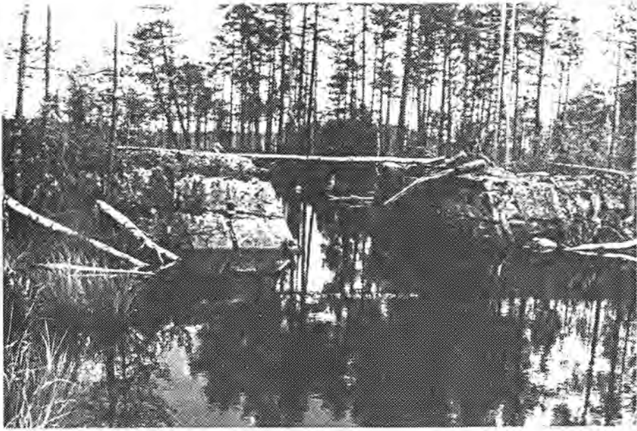
Stenmyrdammen, sett fra nord
