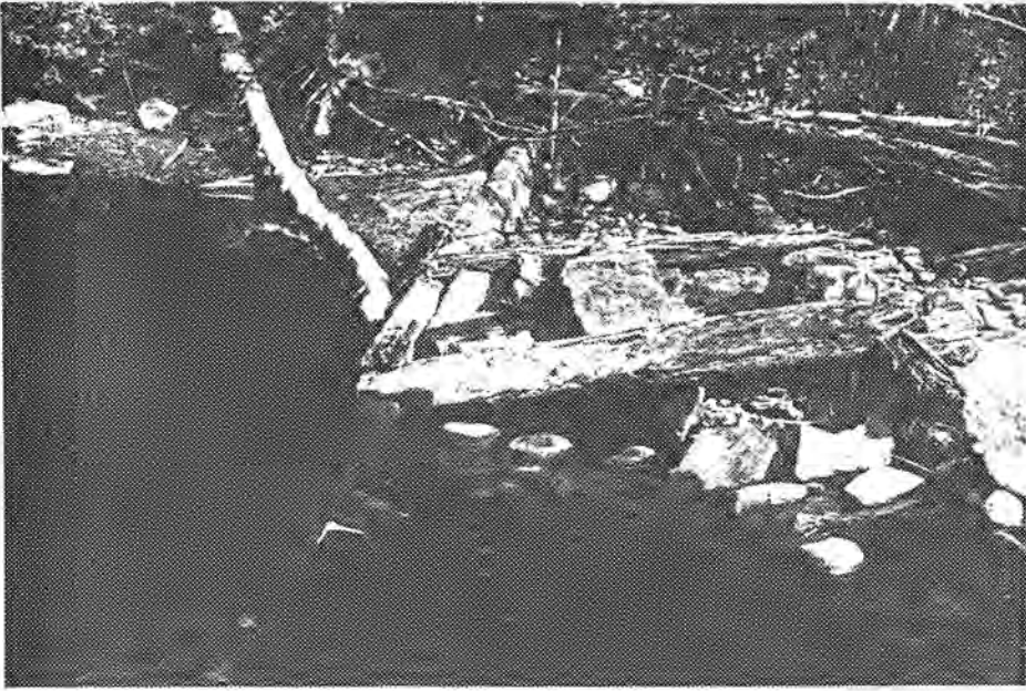
Ruin (gamle) Sætermyrdammen, sett fra nord
