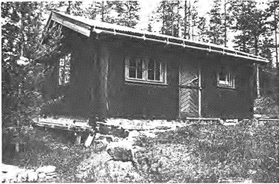
Koie ved Vålmangdammen, sett fra nord
