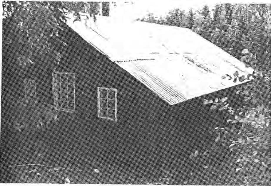
Fløterkoie ved Storbronkdammen, sett fra sør/vest
