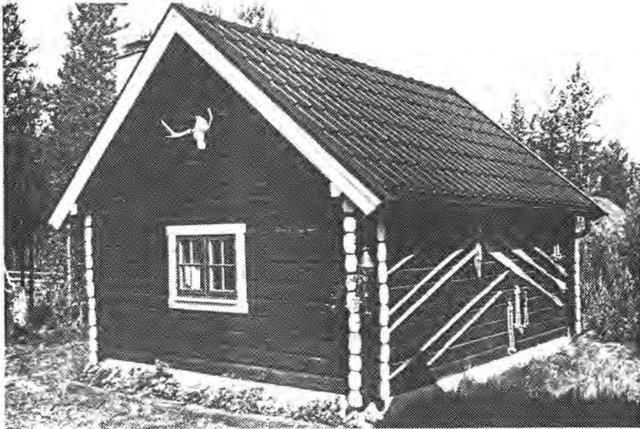
Koie ved Vermunddammen, sett fra vest
