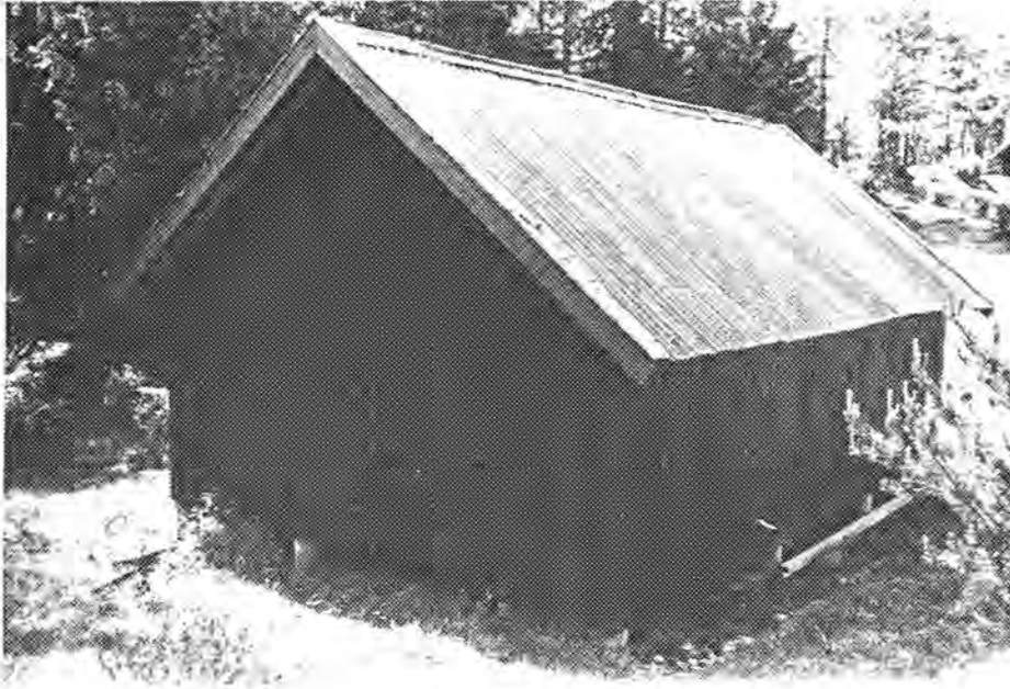
Båthus ved Kynndammen, sett fra vest
