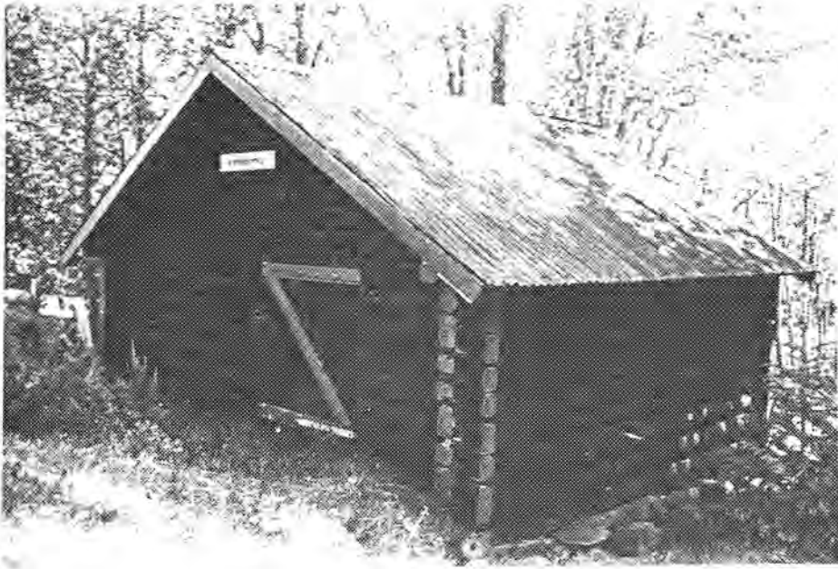
Bu ved Kynndammen, sett fra nord
