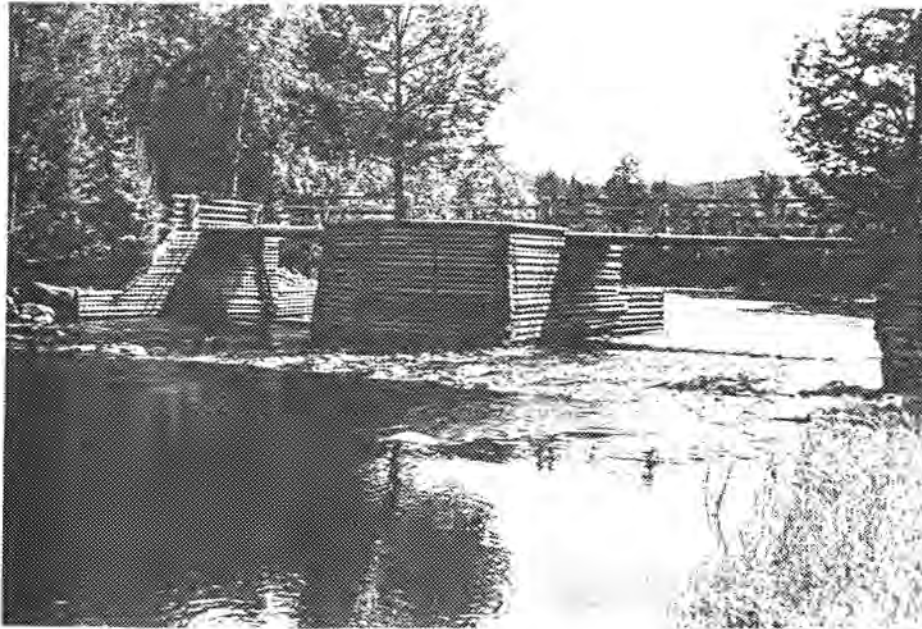
Kynddammen, sett fra sør/øst
