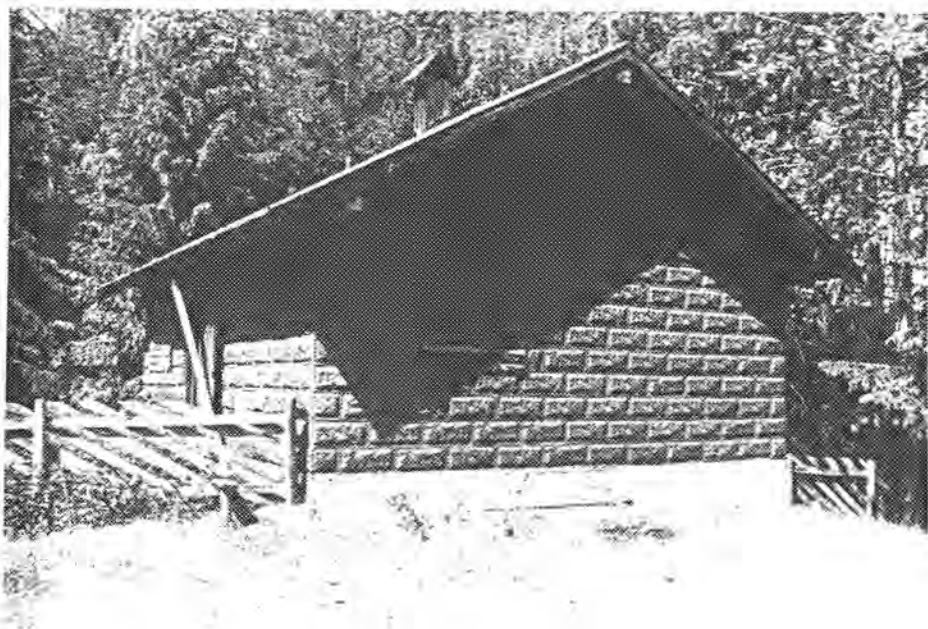
Fjøs ved Kynndammen, sett fra nord
