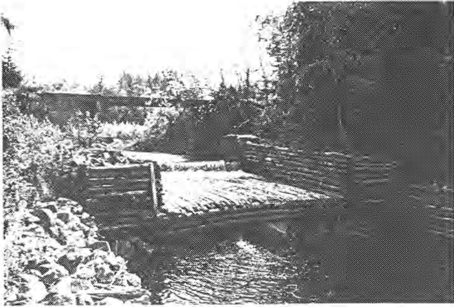
Skådam/damgulv, sett fra sør
