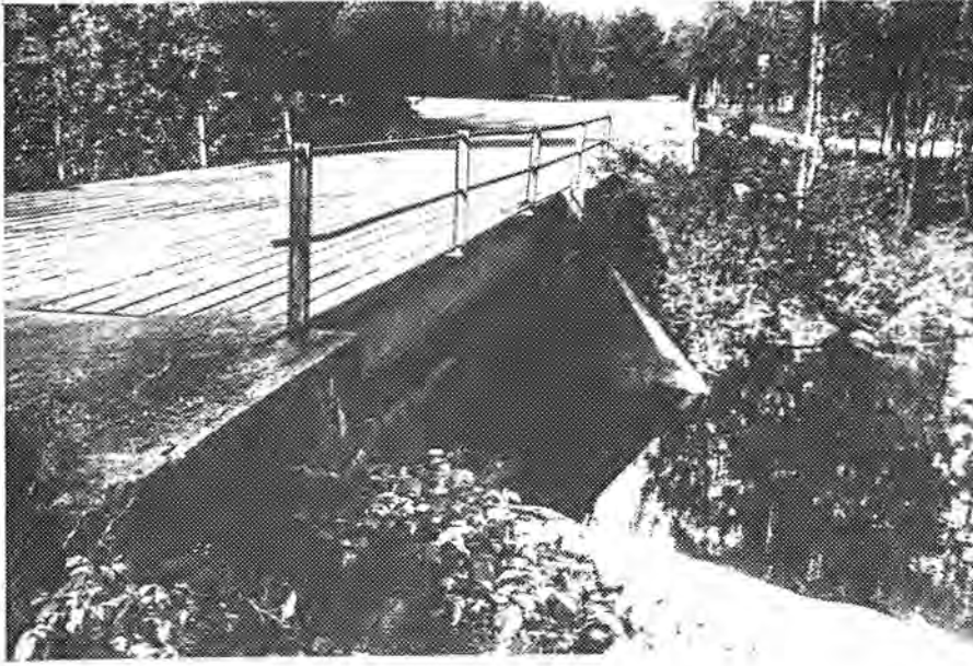
Fløytdammen, sett fra sør
