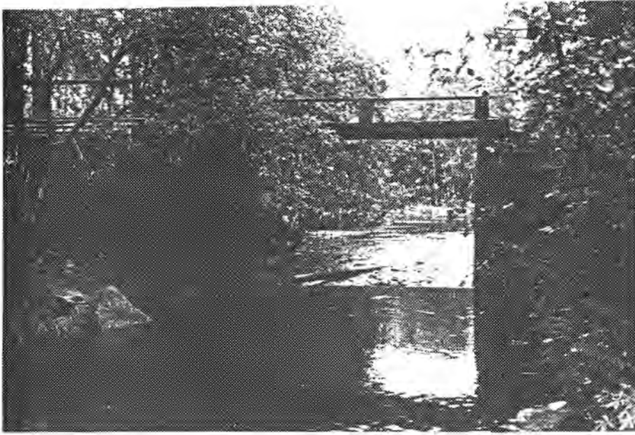
Korsfløytdammen, sett fra nord
