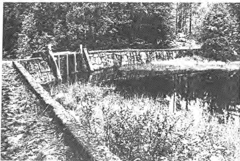
Nøkkjerndammen, sett fra vest
