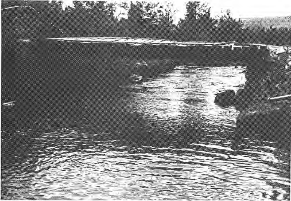
Nedre Ulvådammen, sett fra vest
