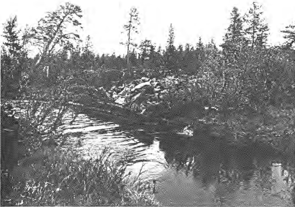
Damkar/damarm, sett fra nord
