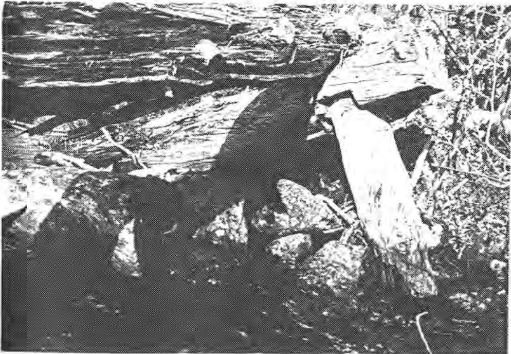
Støttebukk ved siden av damåpning, sett fra vest
