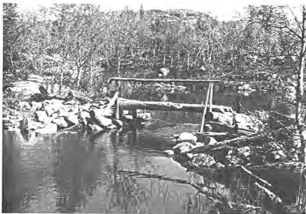
Båthusdammen, sett fra nord/øst
