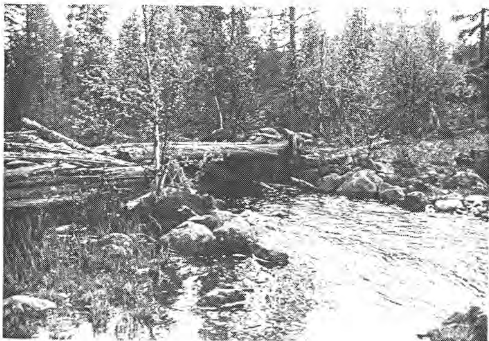
Tolgesjødammen, sett fra sør
