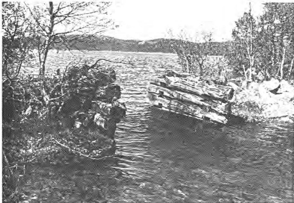
Volsjødammen mot vannmagasin, sett fra nord
