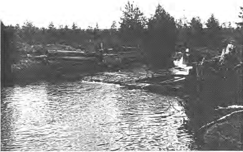
Øvre Ulvådammen, sett fra øst
