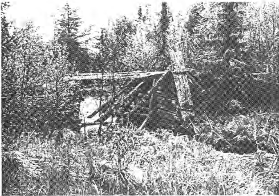
Hølbekkdammen, sett fra sør
