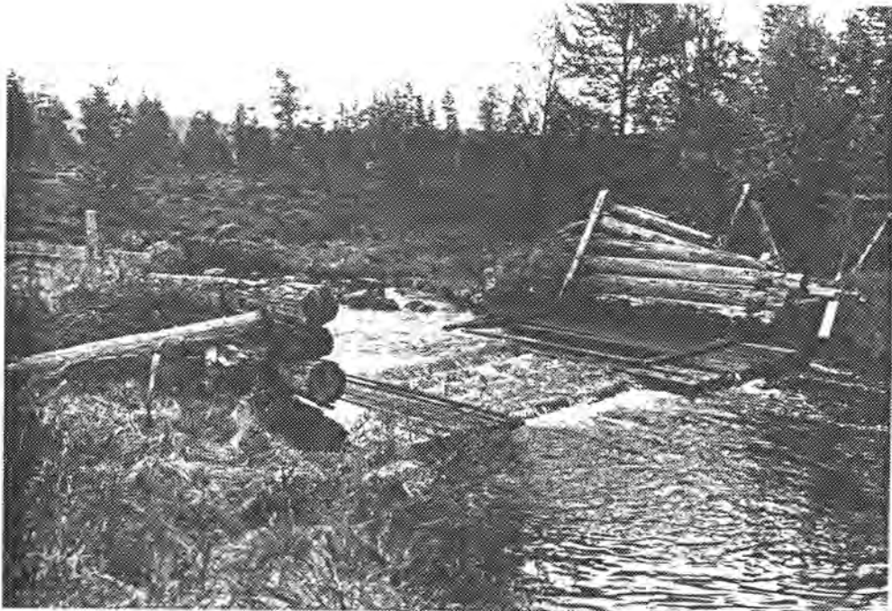
Øvre Ulvådammen, sett fra sør
