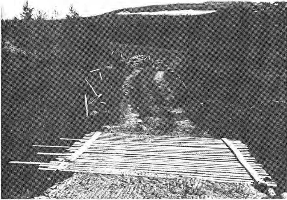
Dambru, sett fra sør
