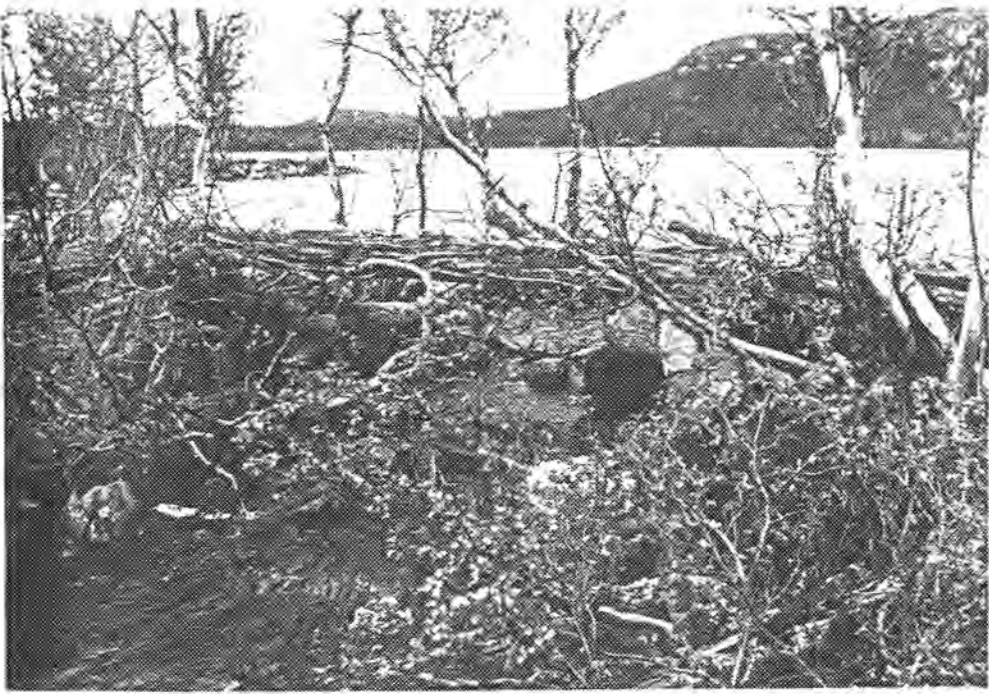
Storsjødammen, sett fra sør
