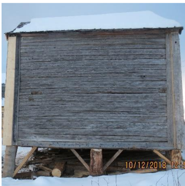
Nordfasade. Foto: Slidre Bygg & Prosjektering AS, 2018
