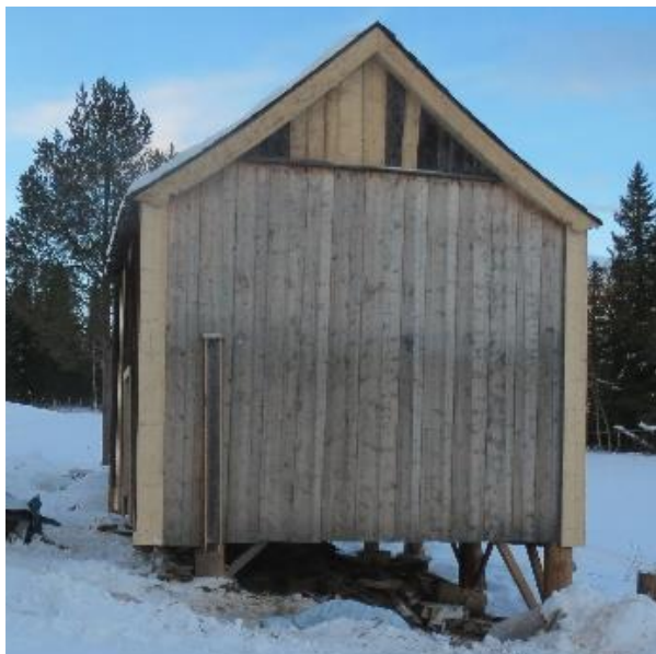
Østfasade. Foto: Slidre Bygg & Prosjektering AS, 2018
