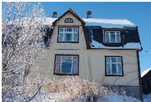
Gulbygningens østfasade. Foto: OFK, 2010
