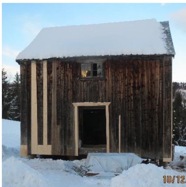
Sørfasade. Foto: Slidre Bygg & Prosjektering AS, 2018
