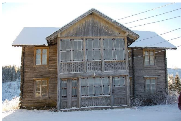
Gamlebygningens nordfasade. Foto: OFK, 2010
