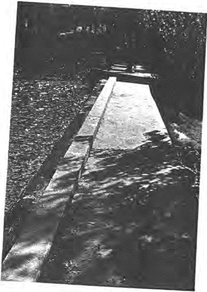
Detalj av damarm, sett fra nord/øst
