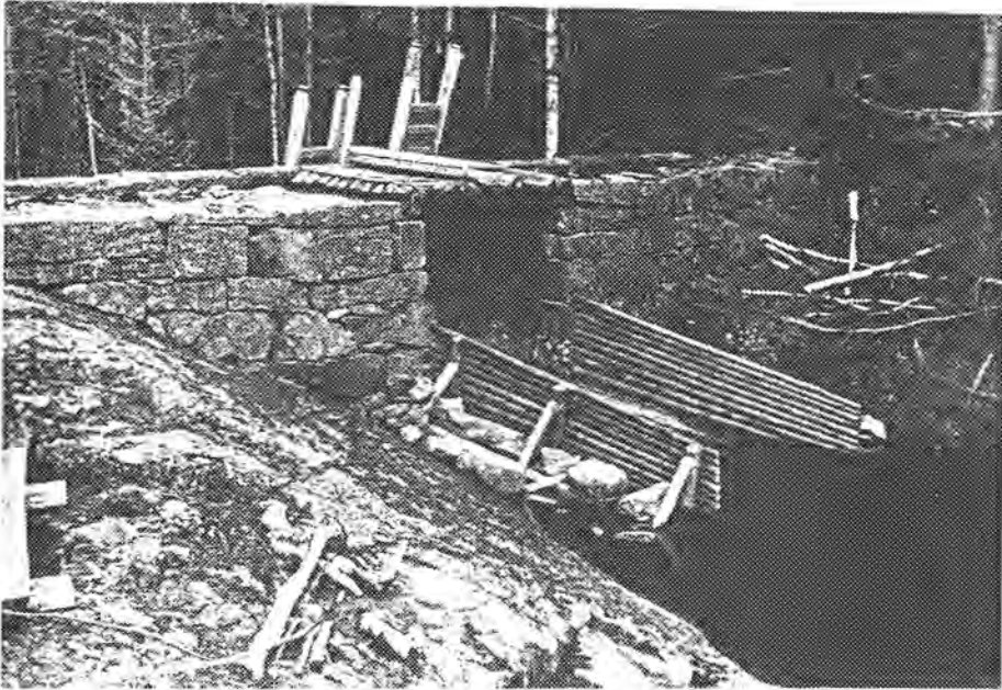
Detalj av damkar, sett fra nord/øst
