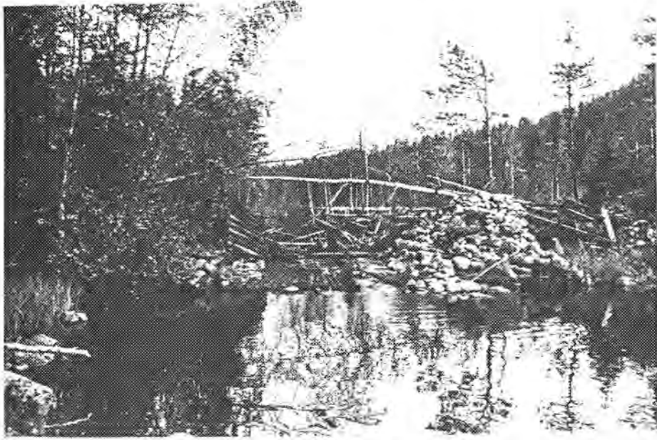
Aursjødammen, sett fra nord
