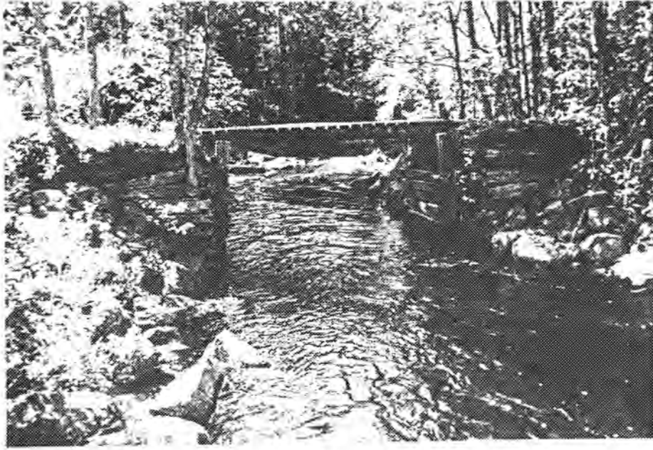
Nøklevanddammen, sett fra vest
