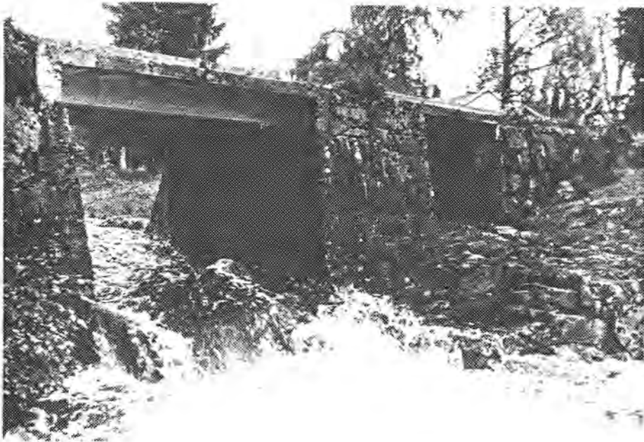
Detalj av damkar, sett fra nord/øst
