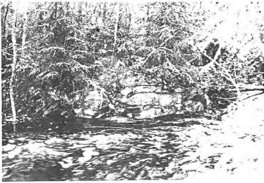
Rest av dam/damkar, Sagåsdammen
