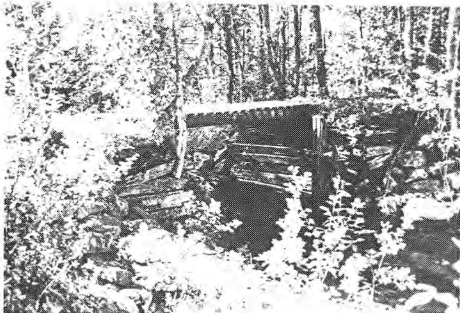
Detalj av damkar, sett fra øst
