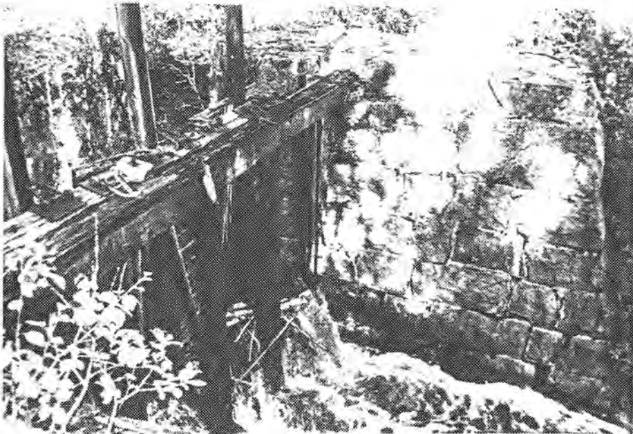
Detalj av damkar, sett fra nord/øst
