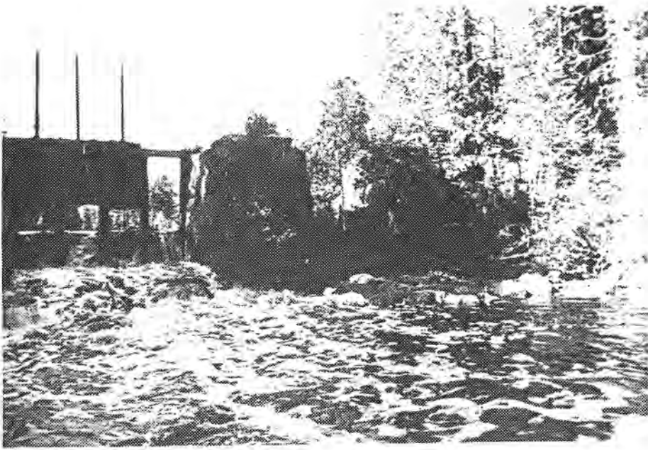
Dam/damarm, sett fra nord
