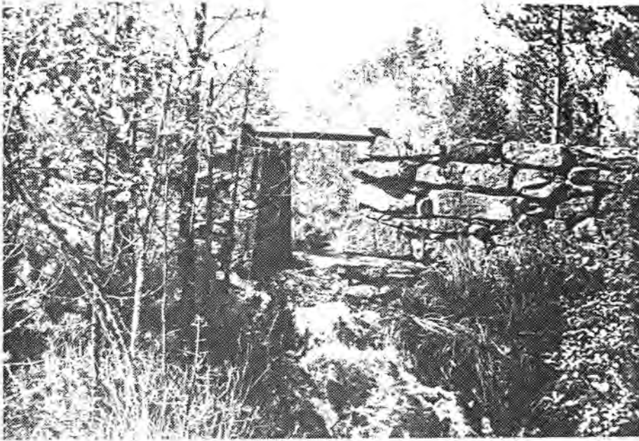
Overløpsdam, sett fra vest
