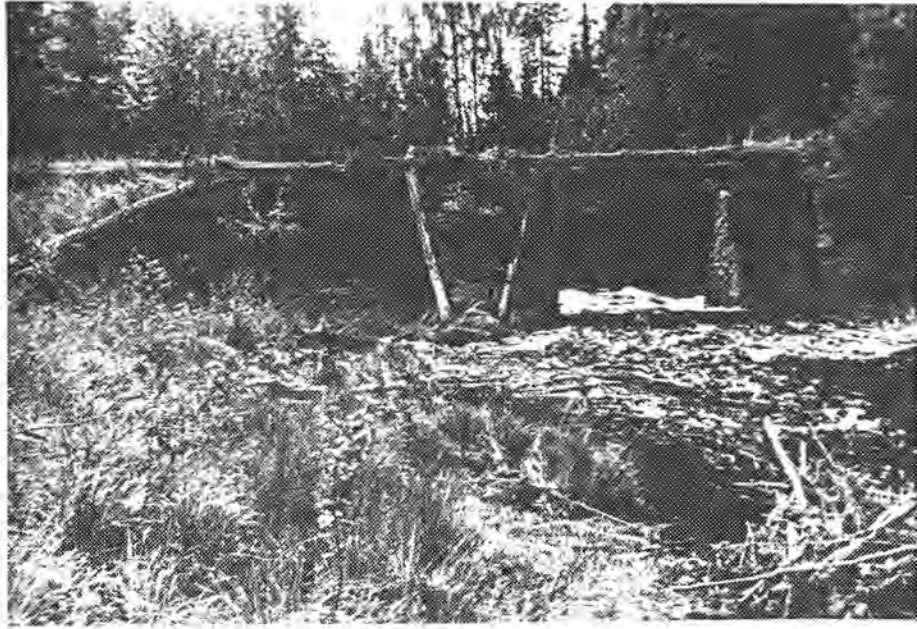
Opakerseterdammen, sett fra sør
