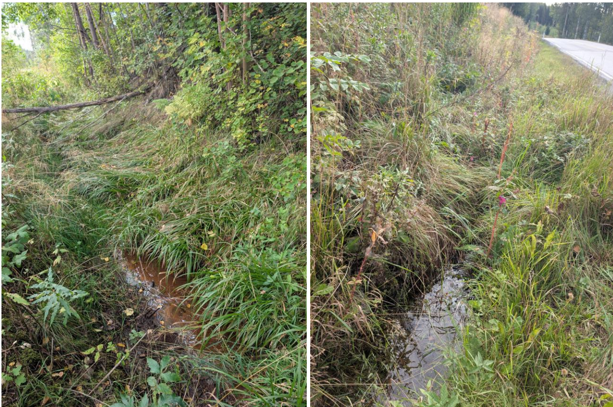
Figur 4-8: Bilde til venstre: Dreneringslinje i vegggrøft som renner på vestsiden av veien. Bilde til høyre: Dreneringslinje i vegggrøft som renner på østsiden av veien. Kilde: Bilde tatt under befaring september 2025, NIRAS.
