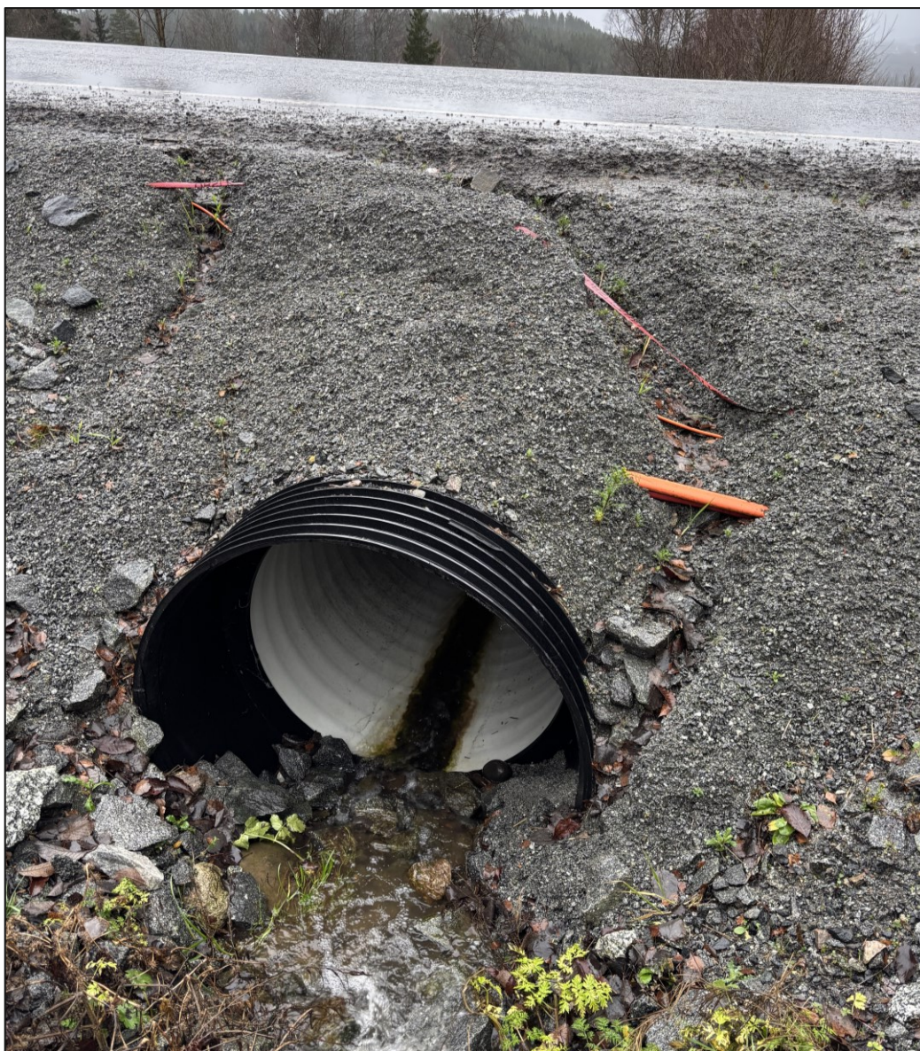
Figur 4.12: Innløpet til eksisterende stikkrenne nr. 3 ved profil 1680. NIRAS Norge AS.
