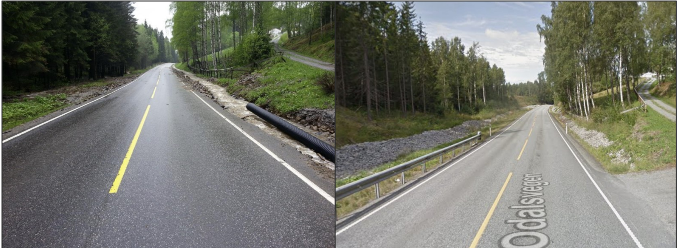
Figur 2.4: Venstre: vegstrekningen under flomhendelsen i 2013. Bildet er hentet fra presentasjon «kurs i vegteknologi» av statens vegvesen [21]. Høyre: Strekningen i 2018, med steinsatte grøfter og utvidet bekkeløp på vestsiden av vegen bildet er hentet fra Google street view. Begge bilder er tatt fra ca. samme sted og er vinklet mot nord.
