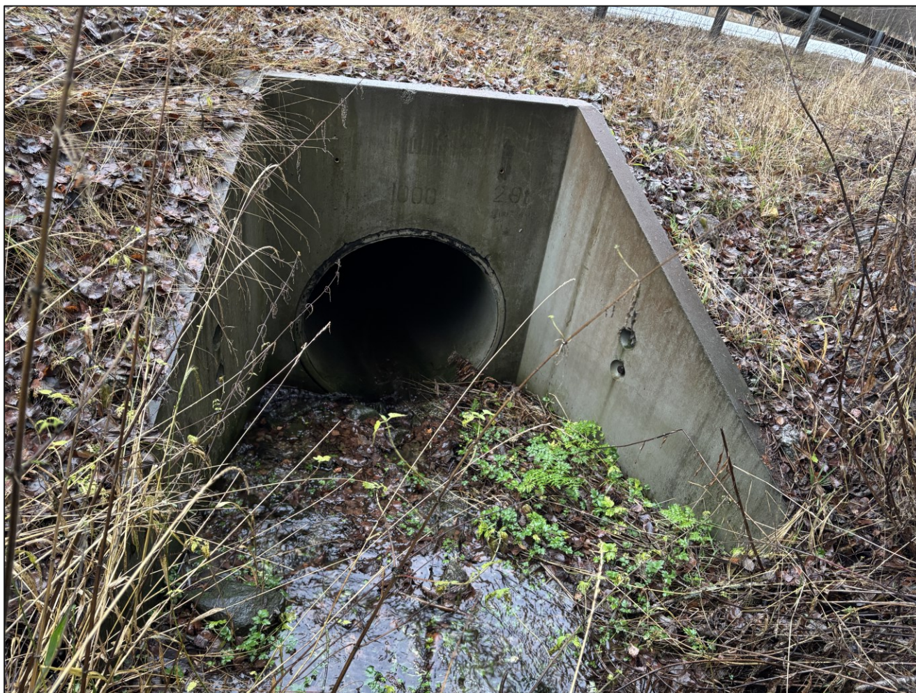
Figur 4.6: innløp på dagens stikkrenne nr. 7 ved profil 1020. NIRAS Norge AS.
