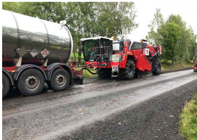
Stabiliseringsarbeid på Fv 216. Foto: Arnfinn Trosterud
