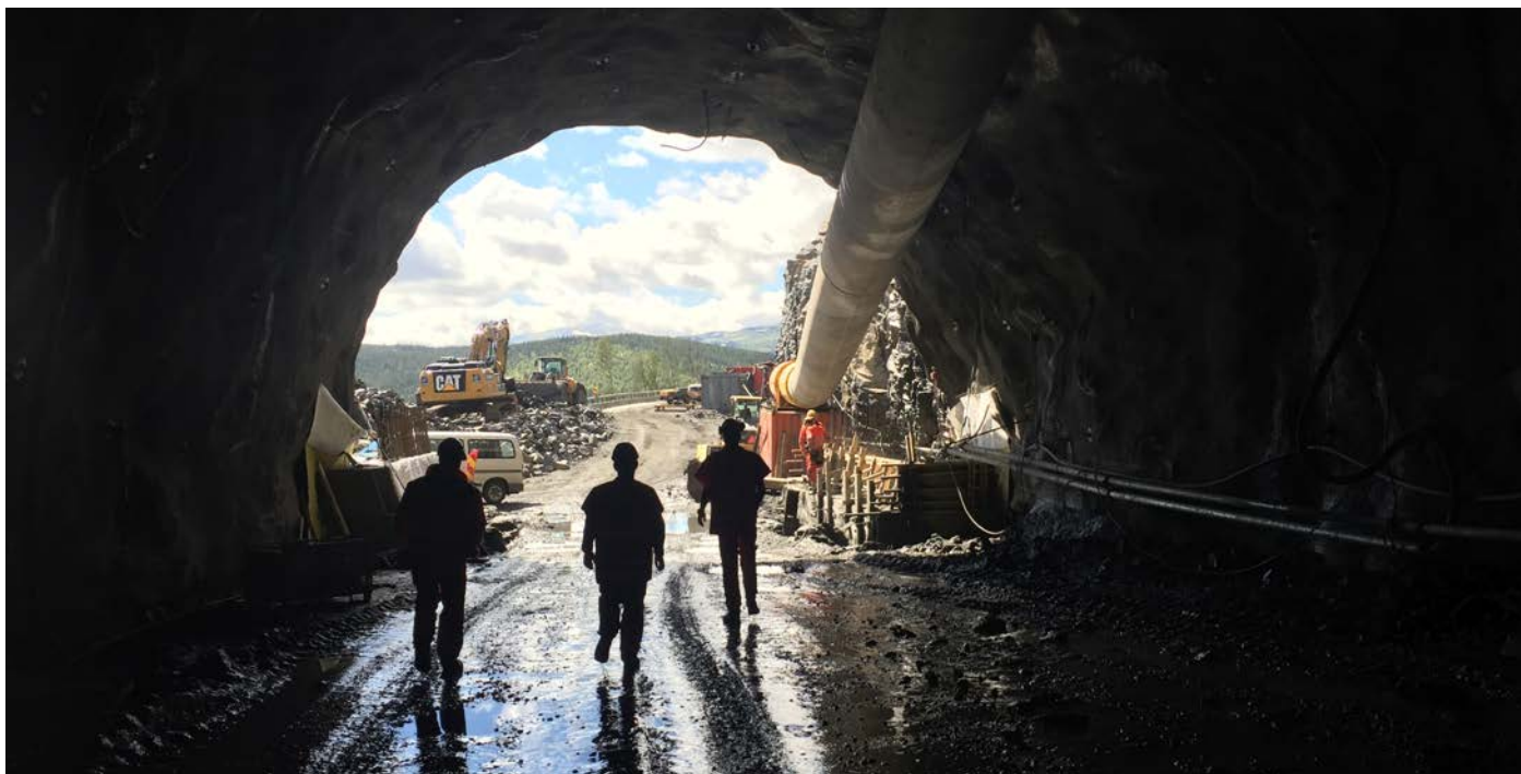
Tunnelen langs fv.255 Skåbuvegen.. Foto: Per Kollstad
