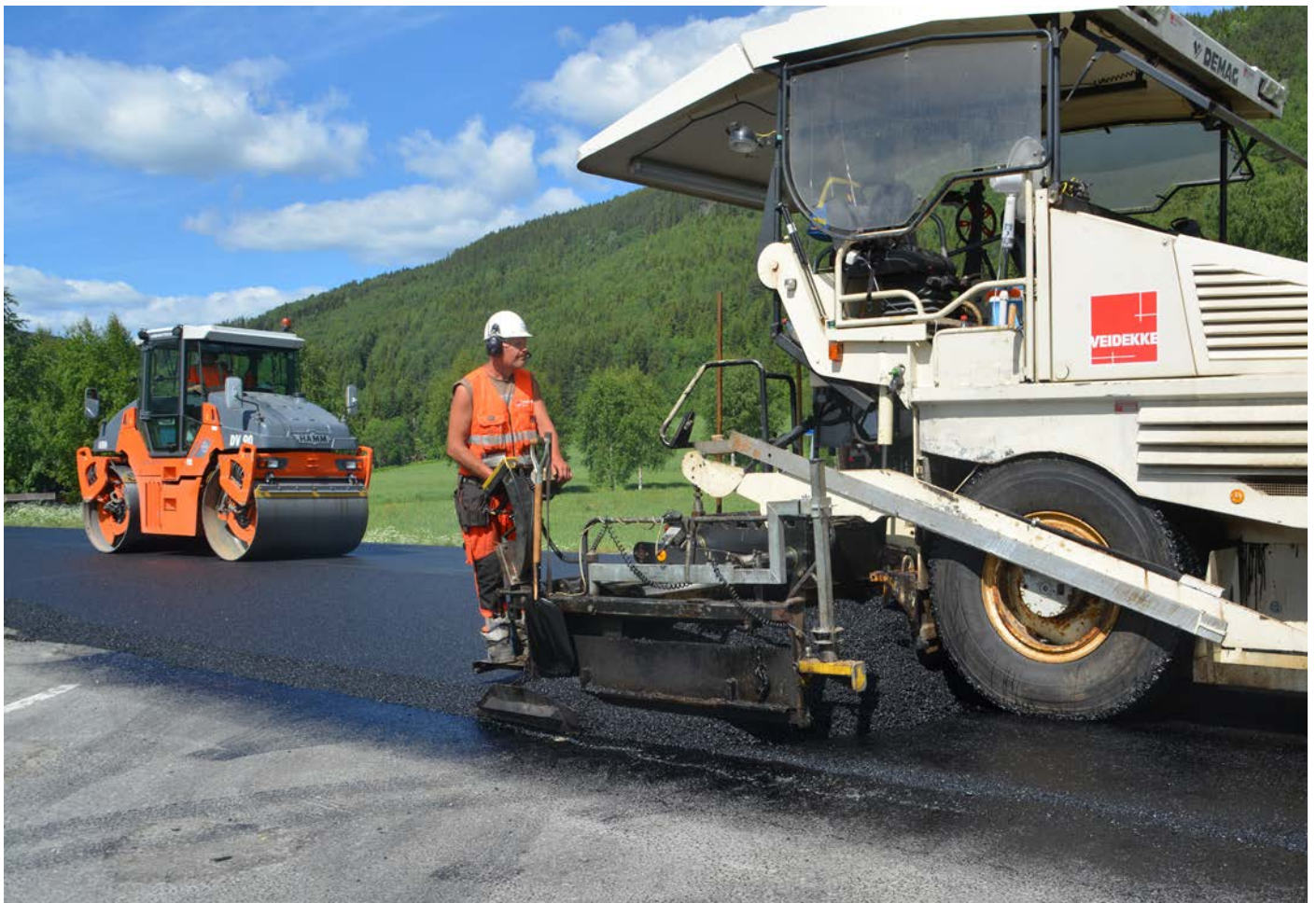
Vegarbeid. Foto: Leila Øvreseth
