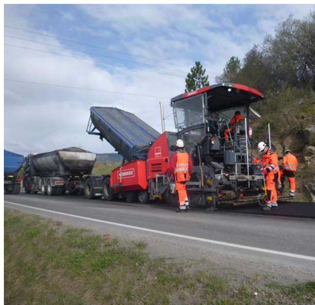
Ny asfalt på fv. 34 i Røykenvika i Brandbu Foto: Kari Hermanrud
