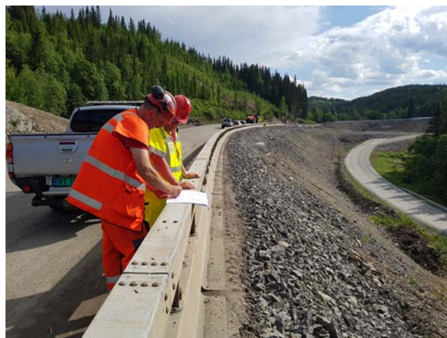
Rekkverksplanlegging, fv. 33, Tonsåsen. Foto: Steinar Svensbakken
