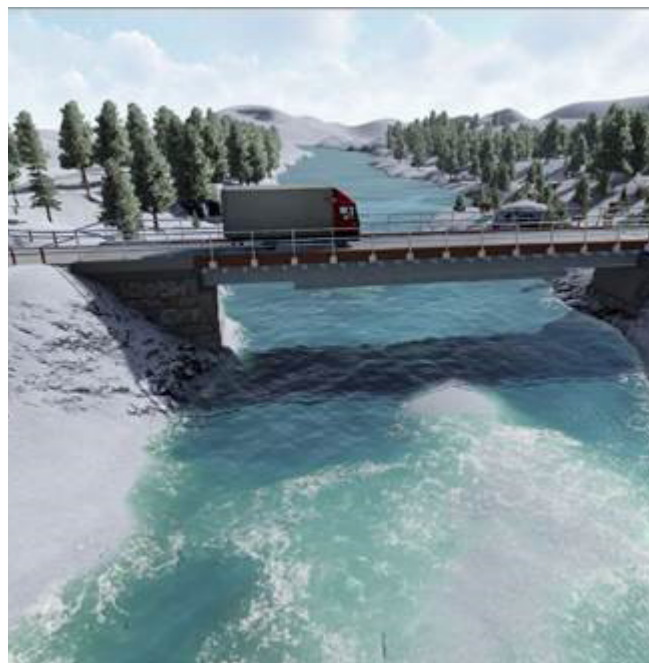
Fv. 217 Elvbrua. Foto: Innlandet fylkeskommune
