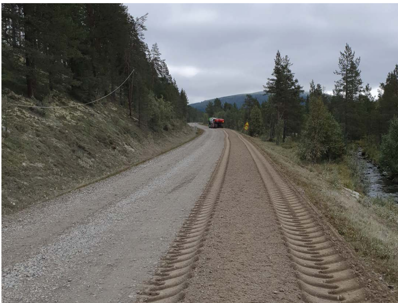
Fv.30 Utbedringsarbeid sommeren 2021 Foto: Kjetil Strømshoved
