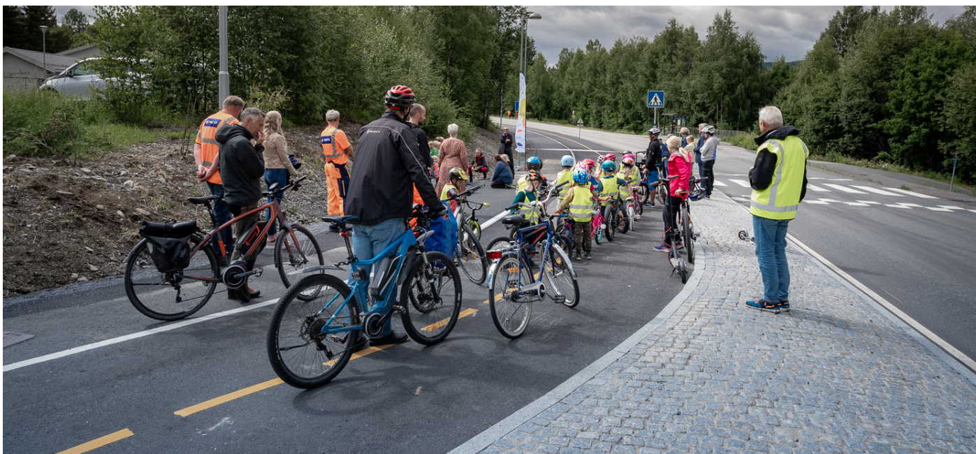
Ny gang- og sykkelveg F. Colletts veg. Foto: Stig Floberghagen
