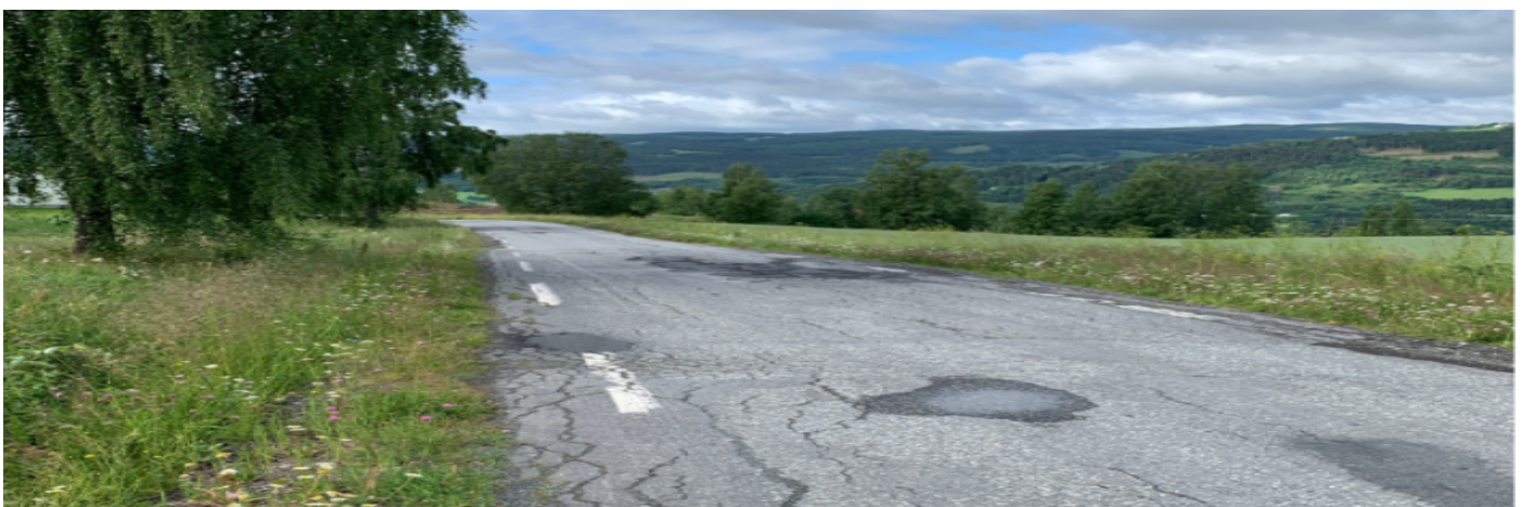
Fv. 2534 Kongsvegen før utbedring. Foto: Anders Fosse Skjåk
