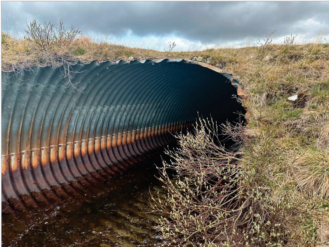
Figur 9: Eksisterende stikrenne, nedstrøms
