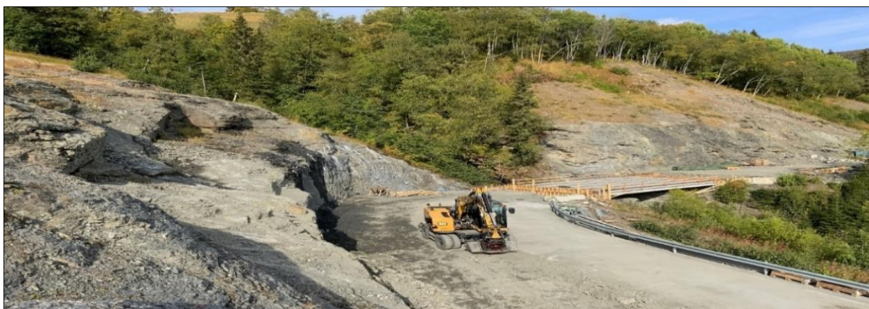
Innlandet fylkeskommune. (bygging av ny Helåa bru på Fv 255 Skåbuvegen i Nord-Fron kommune) Foto: Oddbjørn Torsgård.
