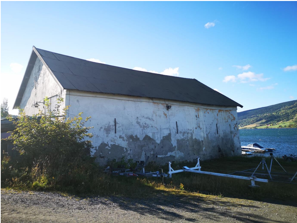
Oppfylt terrenget mot nord følger nå omtrent langs bygningens overgang mellom grunnmur og murvegg
