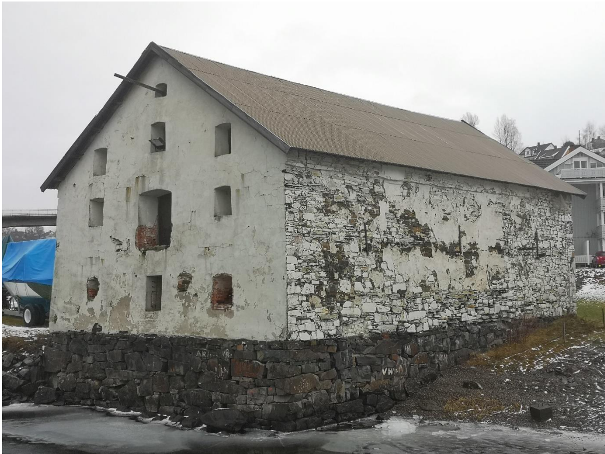
Murverket kan til en viss grad studeres og tolkes ved Thorstadbuas sørlige langvegg
