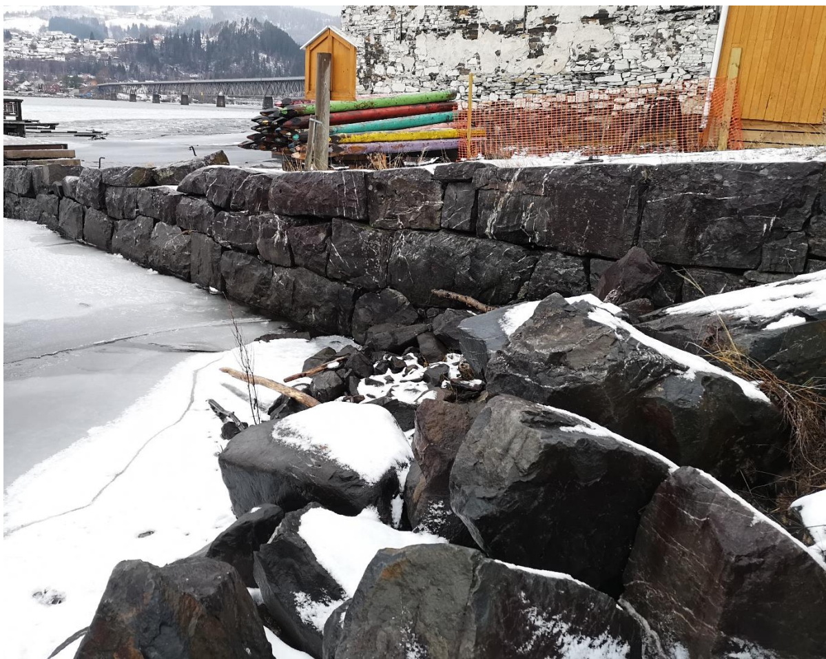
Her vises steinlass i forgrunnen og kunstinstallasjon i bakgrunnen
