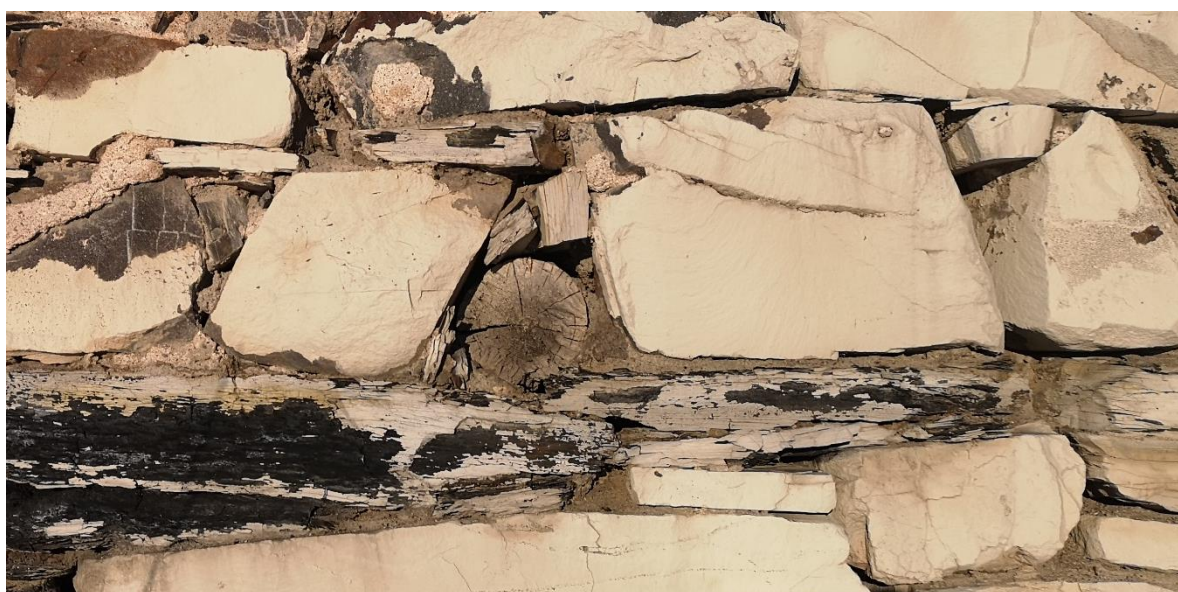
Rundstokker i murverket er gjennomgående og bærer spor av å være hugget av med øks.
