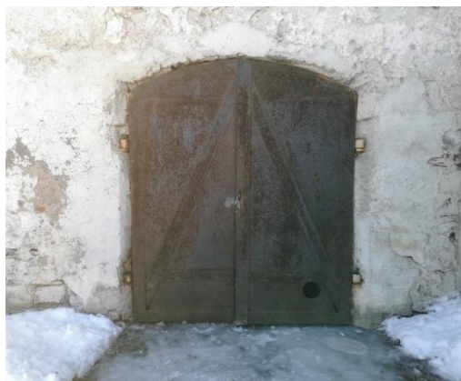
Tunge, klinkede jerndører. Godset i selve dørbladet er omtrent en centimeter tykt
