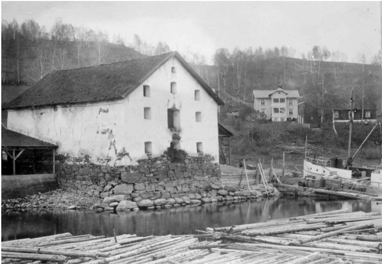
Her kan vi skimte den nordlige vangen i steinbrygga. Ved Thorstadbua kan vi legge merke til taksteinen på taket, og vi aner konturene av hvordan vannspeilet ved normalvannstand tidligere støtte i mot nordveggen hvor det nå er lagt fyllmasser. (Foto Maihaugen)
