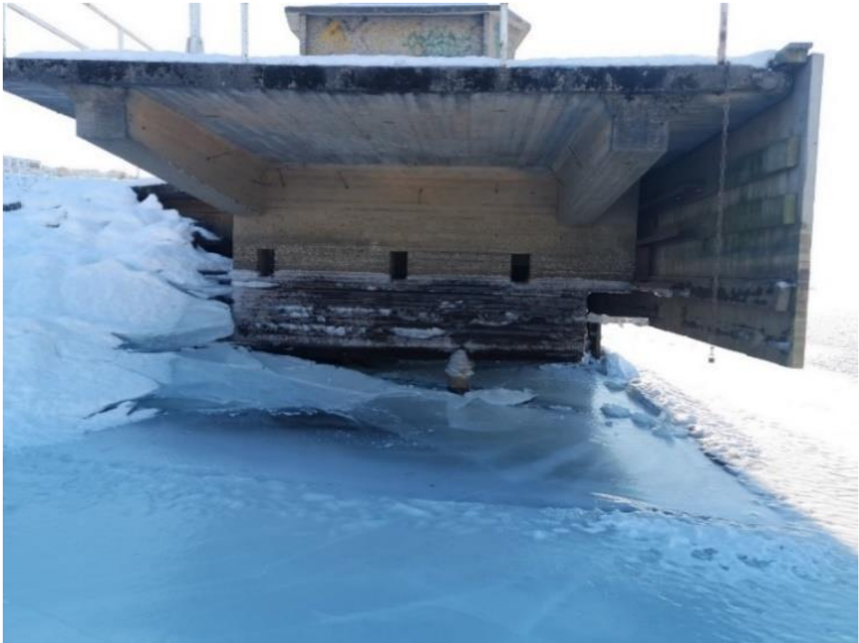
Konstruksjonen kan leses ved lav vannstand. Vi skimter at søyleformede elementer bærer det hele
