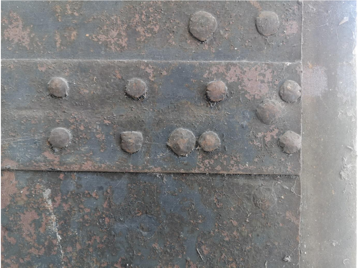
Den manuelle klinketeknikken ved dørene er som tatt rett ut av skroget på mange av datidens båter
