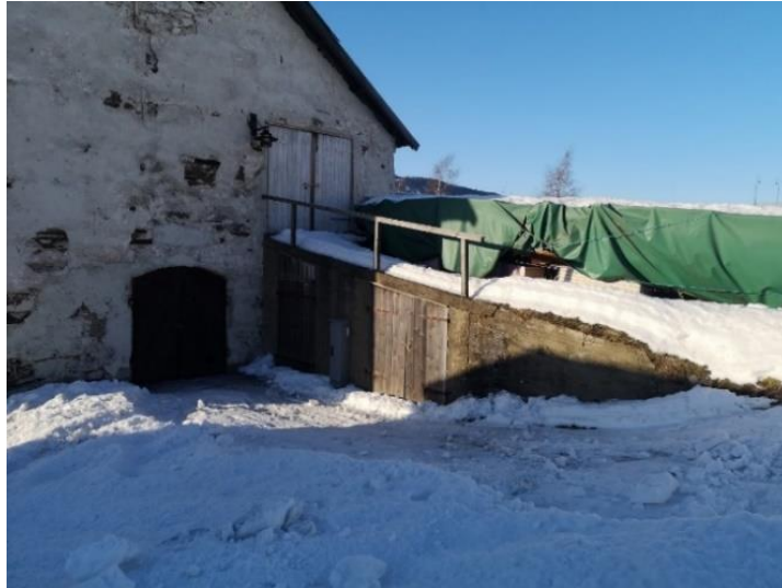
Den støpte kjørebrua og tilhørende portåpning i andre etasje i bygningen er tilført i forrige århundre
