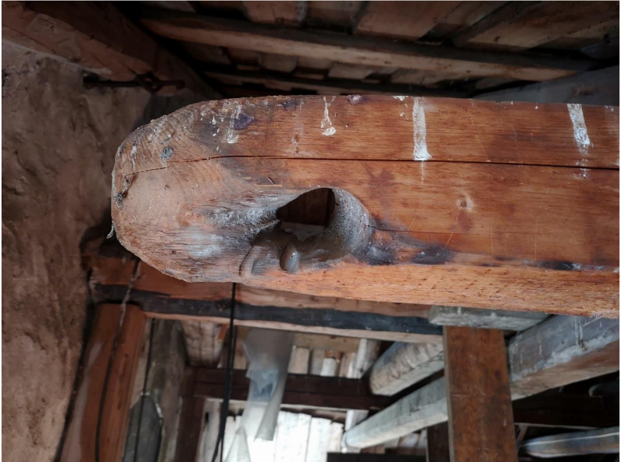
Den borede øyingen bærer slitemerker etter kjetting. Slitasjen i enden av stokken er markant. En forhistorie fra lensen er sannsynlig ved denne reima/svilla ved takstolen, før den ble skåret til på oppgangssag.
