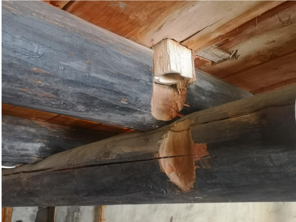
Gjennomføring i etasjeskille for tau som betjente vinna
