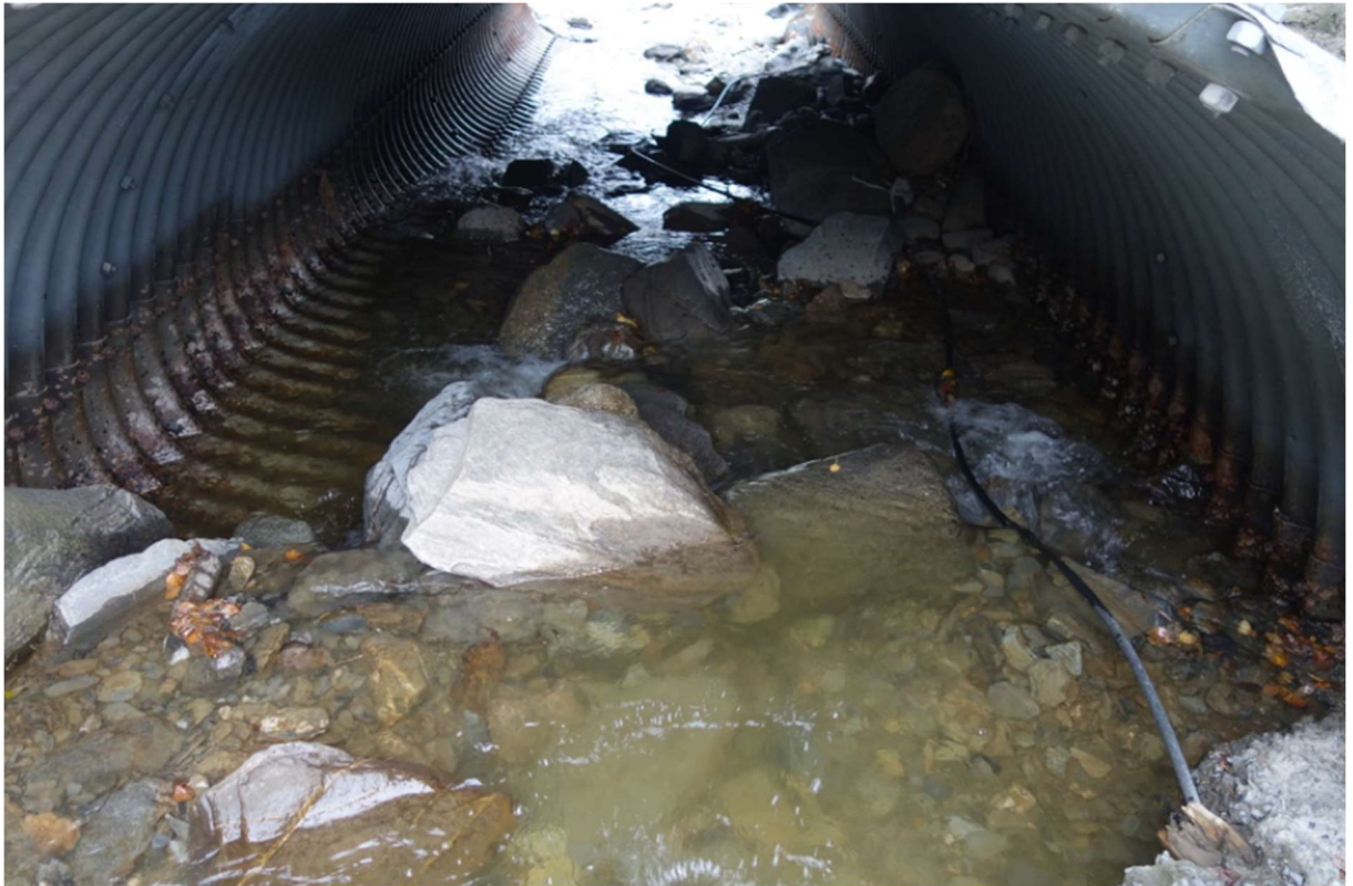
Figur 9. Gjentetting i dagens kulvert.
