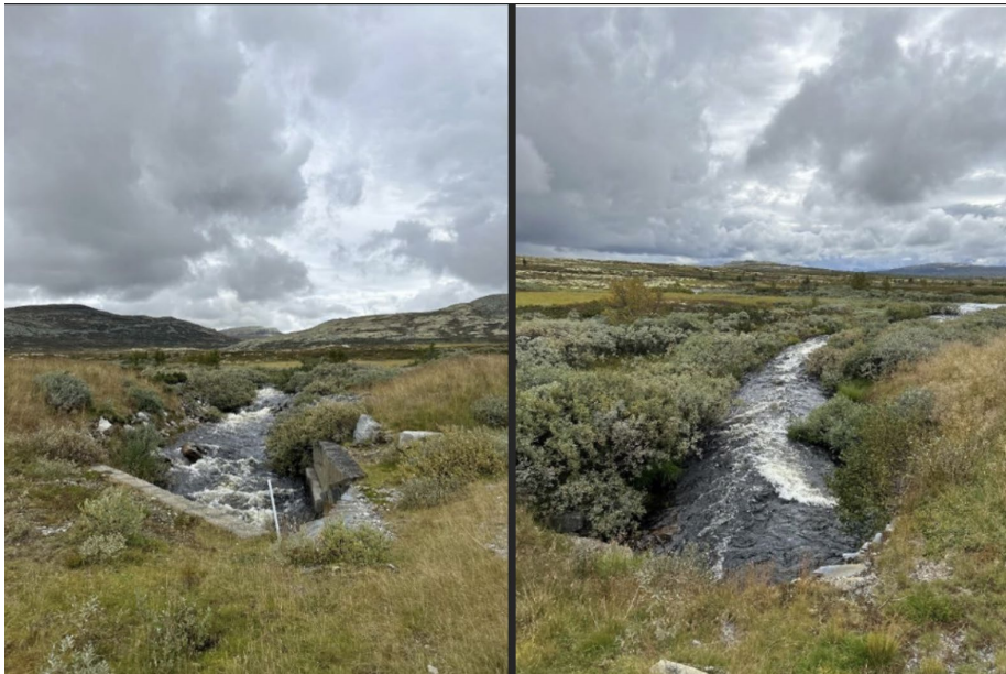
Figur 10: Bildet til venstre viser Bølbekken ved innløpet under fylkesvegen (Foto: Janicke Haug, Sweco), og bildet til høyre viser utløpet under fylkesvegen (Foto: Mari Halvas-Svendsen, Sweco).
