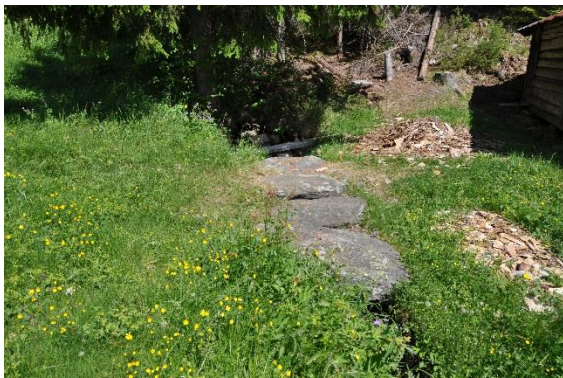
Steinsetning over bekk
