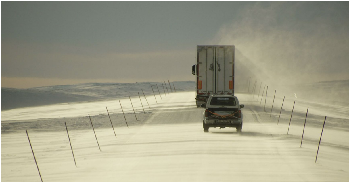
Figur 3: Illustrasjon av en effekt hvor vinden blåser snøen over vegen, i stedet for at den legger seg i vegbanen.
