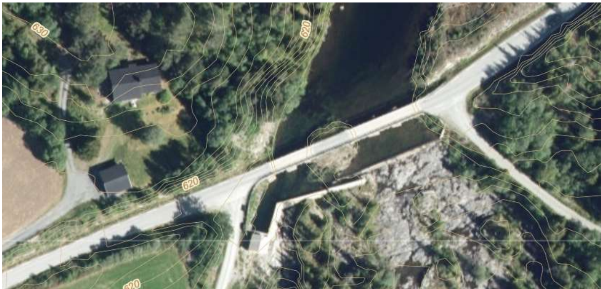
Bilde viser adkomsten på begge sider av brua. Boligen Skøltevegen 159 vest for brua. Damanlegget for Skoltefoss kraftverk rett nedstrøms eksisterende bruer.
