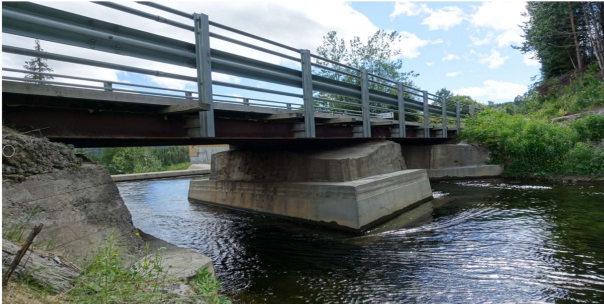
Bildene viser dagens to bruer, med de tre fundamentene i elva som skal fjernes ved bygging av ny bru.
