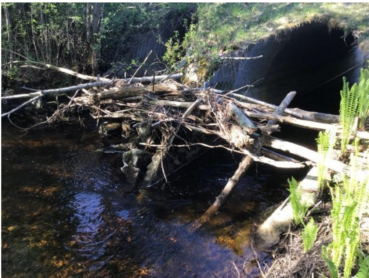
Figur 8-17 Drivved foran innløp til kuvert (Foto: EFLA)
