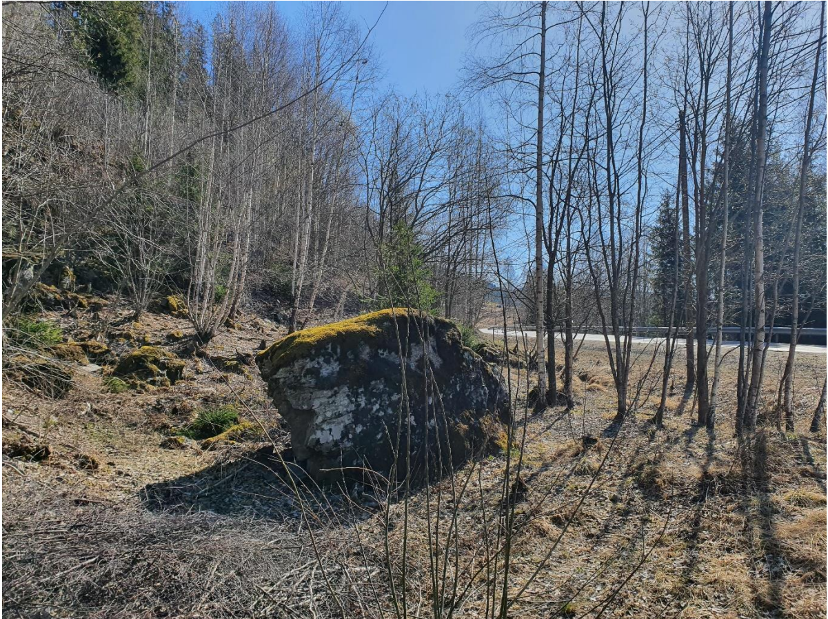
Figur 14. Steinsprangblokk med lengst utløp. Fv 33 sees til høyre i bildet.
