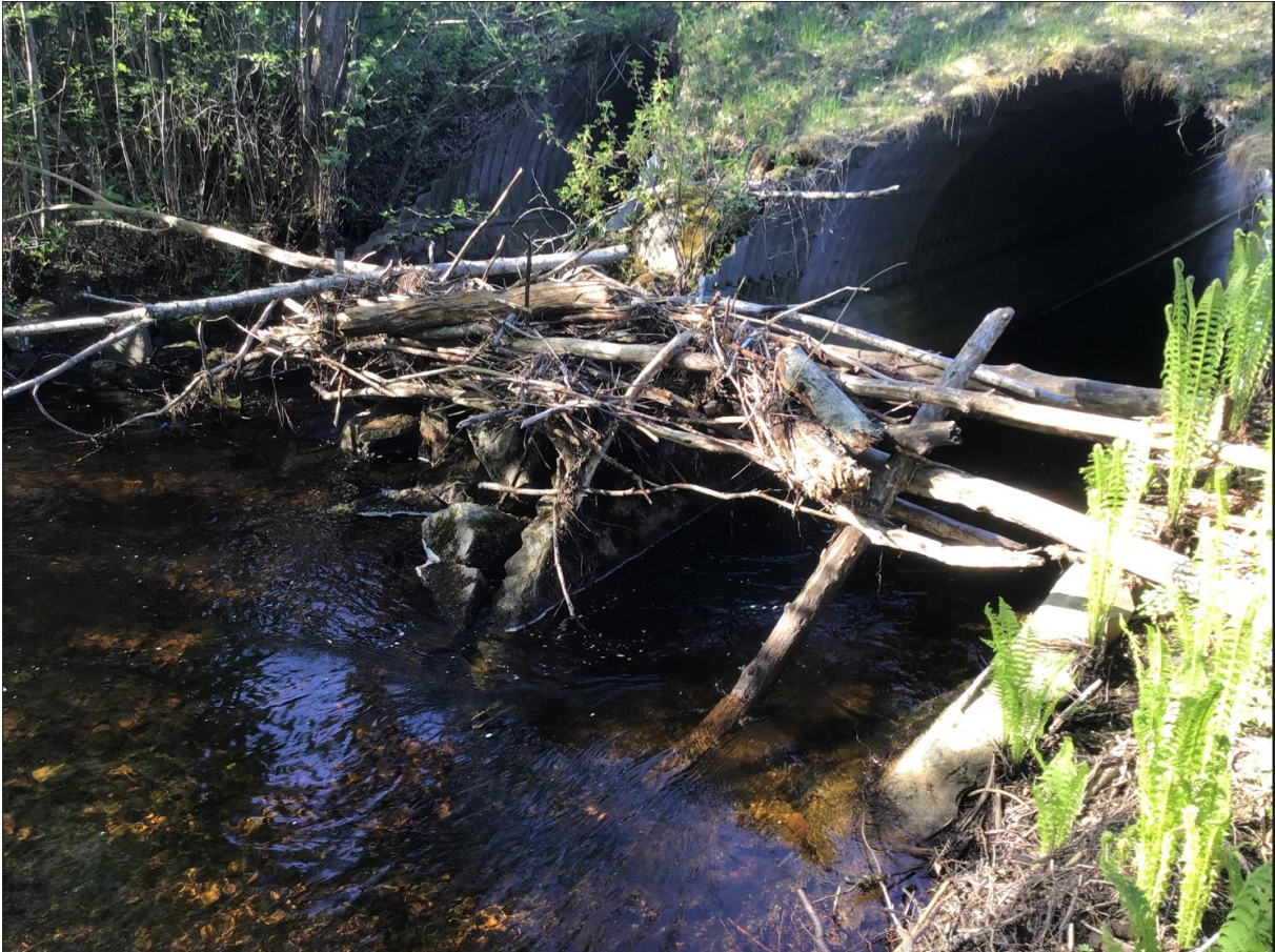
Figur 1.6: Driftved oppsamlet foran innløp
