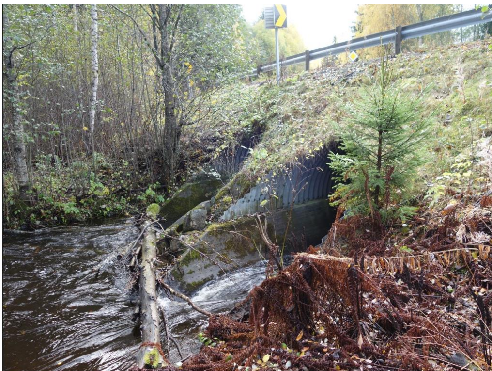
Figur 1.4: Innløp på eksisterende stikkrenner
