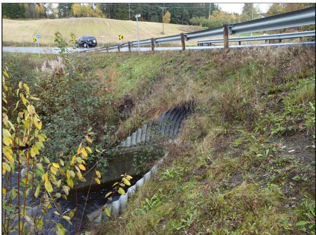
Figur 1.5: Utløp på eksisterende stikkrenner
