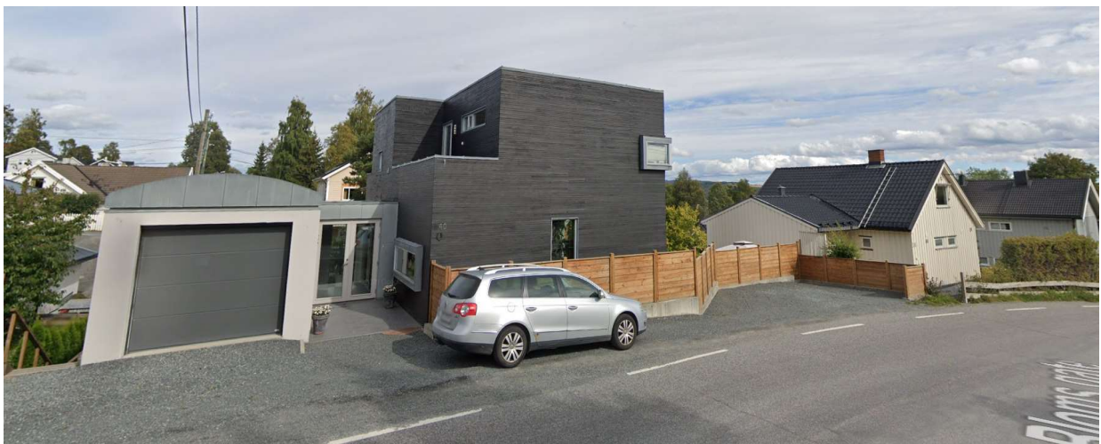
Bilde viser eksisterende situasjon for Prost Bloms gate 40.
