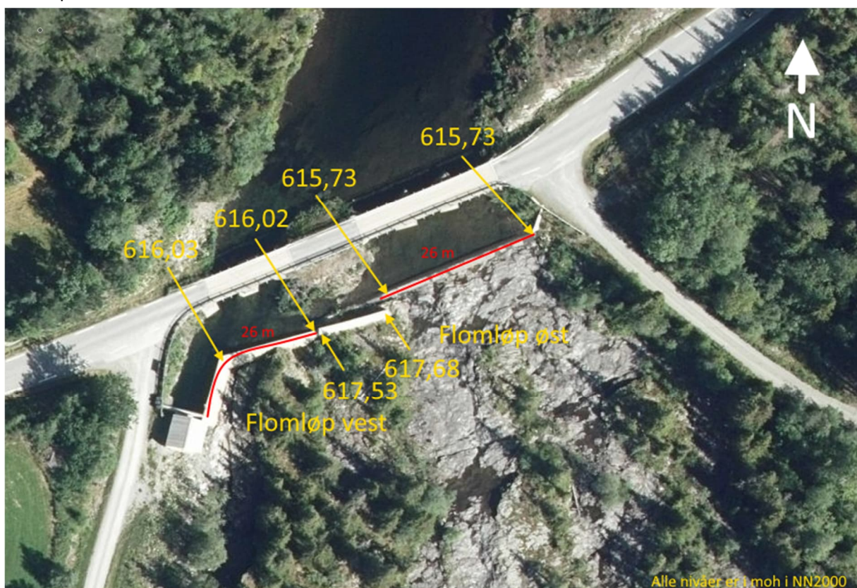
Figur 1 Flomløpene, mellom dem er flommuren og kraftverkets innløp nede til venstre. (Fra norgeskart.no)
