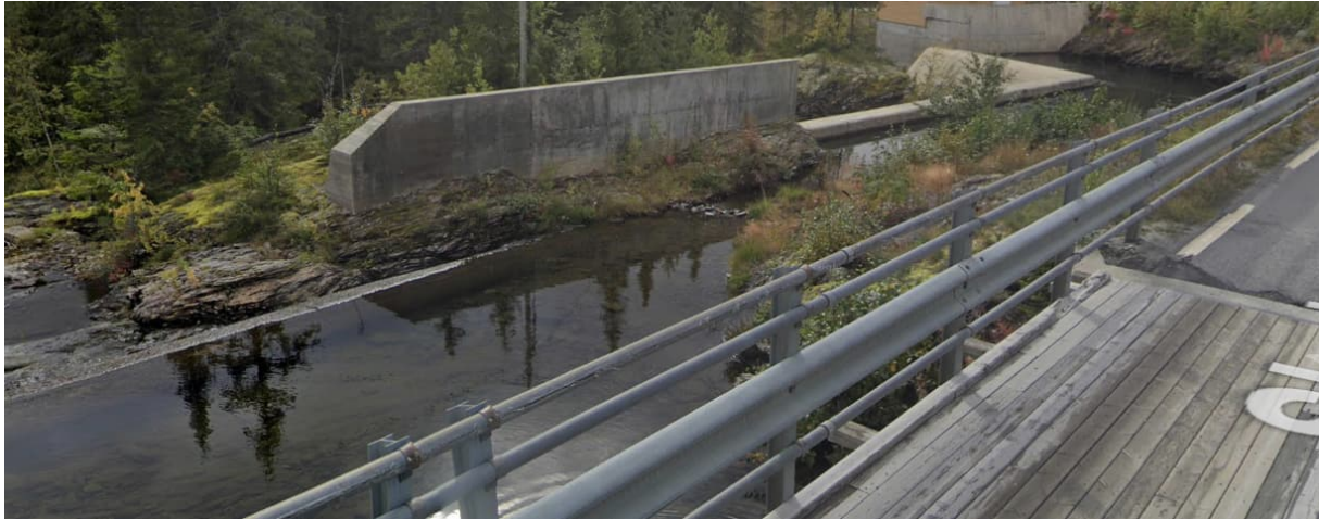
Figur 2 Flomløpet og flomveggen. Det østlige flomløpet er nærmere. (Fra gatekart).
