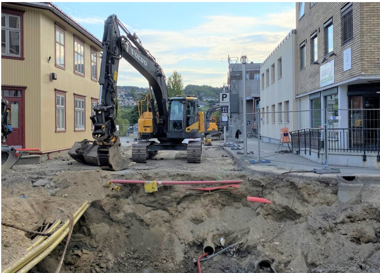
Arbeid med VA-anlegg. Graving i Brugata på Kongsvinger.
